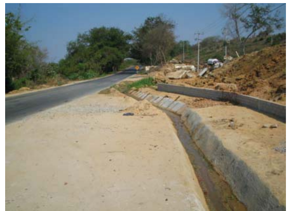
Ampliación de Carretera Federal No. 200
