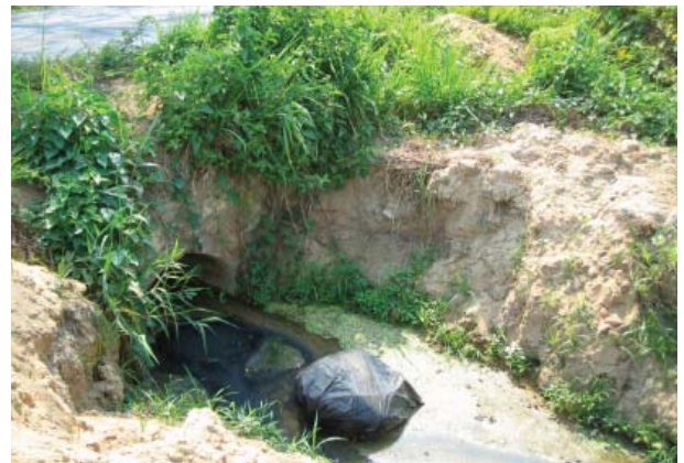
Contaminación por aguas negras
