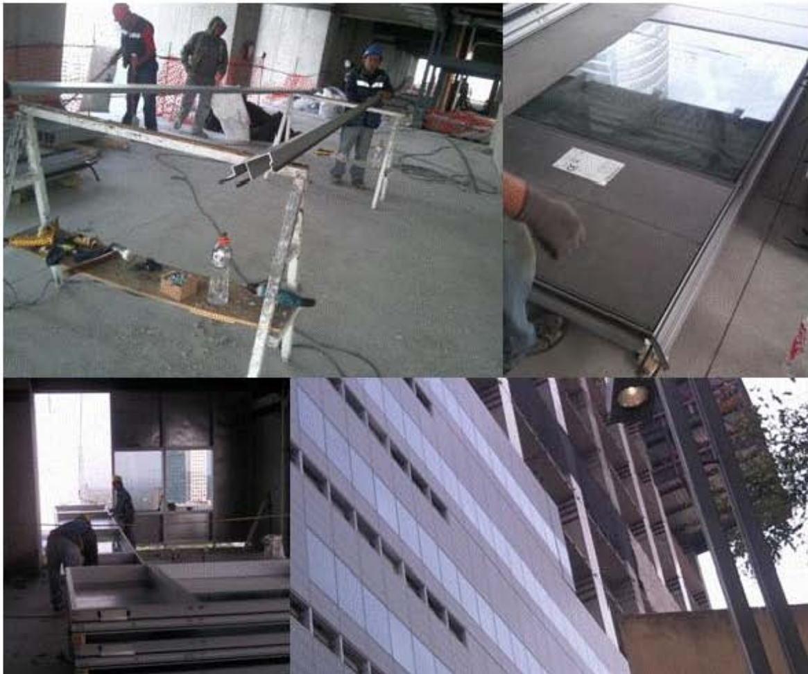
Img. 6. Proceso de montaje de la fachada en Reforma 412 (Torre Diana).
