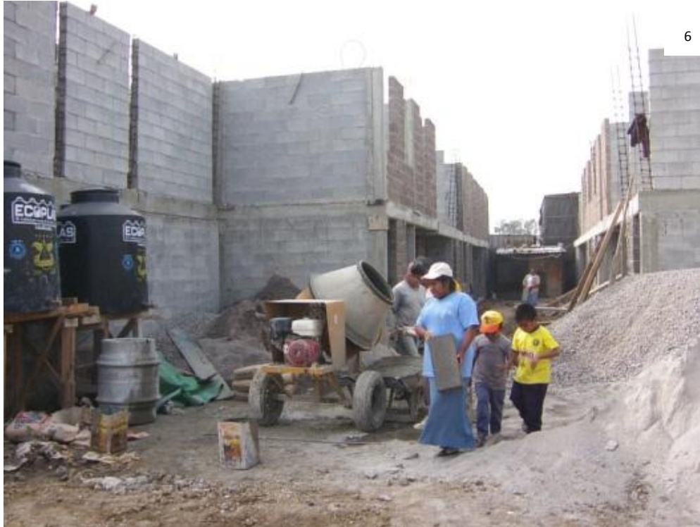
Proceso de construcción de la vivienda indígena Ve'tucua'ja, en la Ciudad de México.
