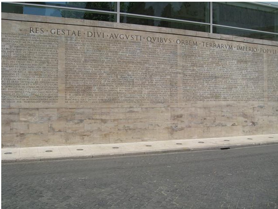
Fig. 5 Detalle de la pared externa del Ara Pacis en Roma.
