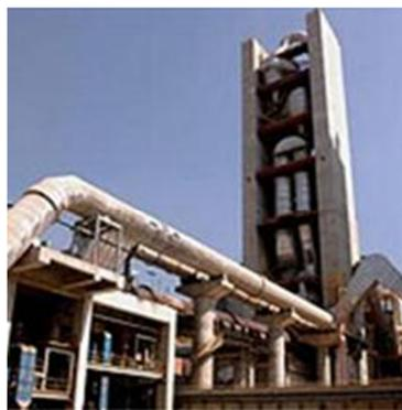
**Figura 12. Edificio precalentador de ciclones.**
