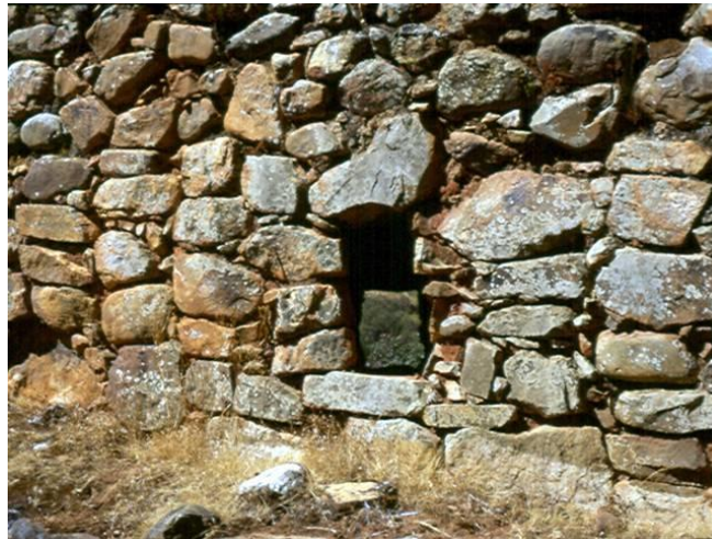
Figura 33. Detalle de tronera en el muro periférico.
