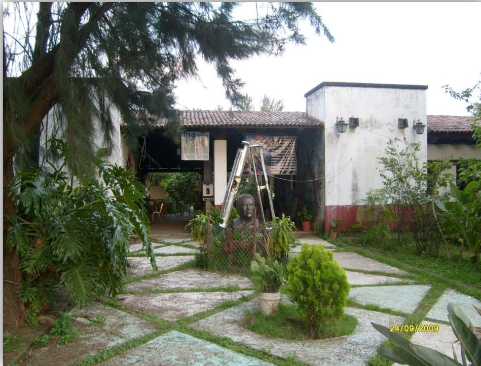
Acceso ppal. a la escuela "Mapeco"
