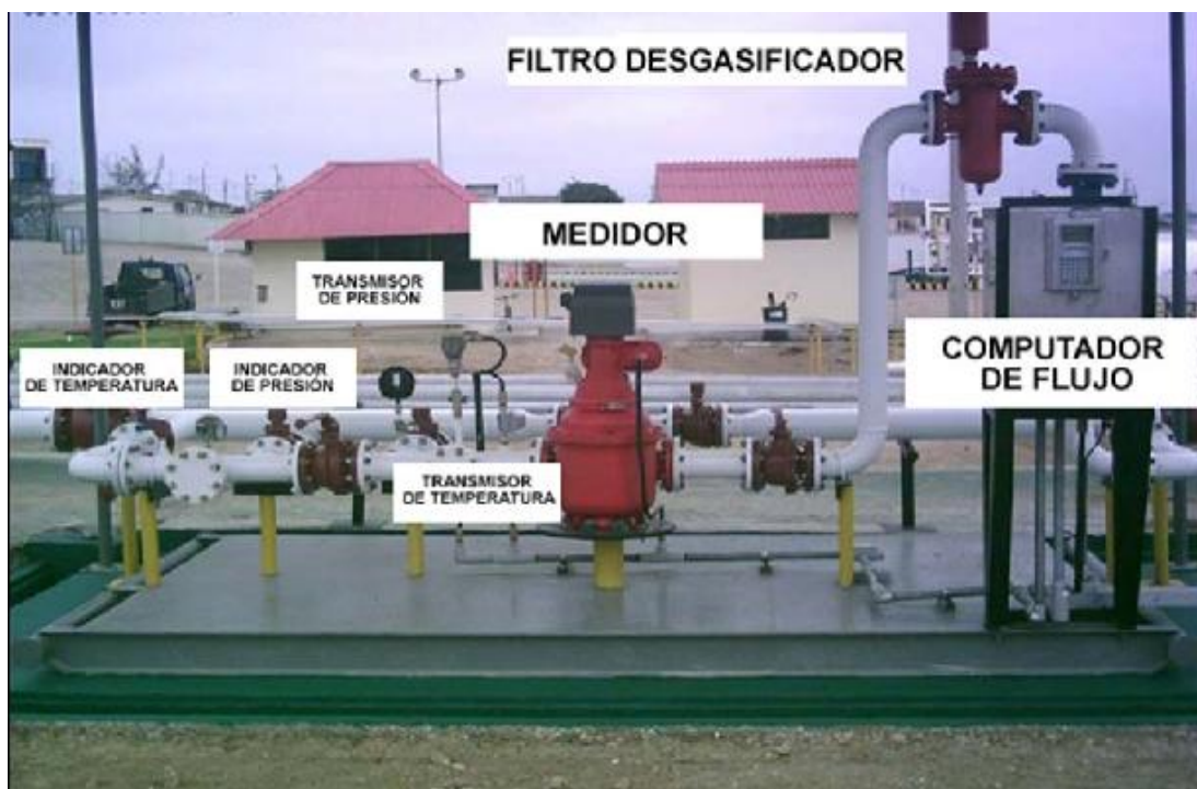
Ilustración 4-1 Principales elementos que conforman un sistema de medición
