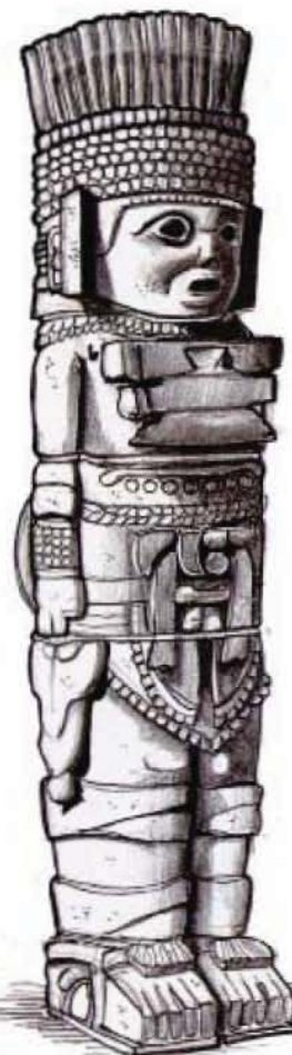
Fig. 3.- Vista parcial de una Columna del Templo de Tlahuizcalpantecuhtli en Tula. Esta columna está compuesta por 4 partes que se integran uniformemente mediante el sistema de CAJA Y ESPIGA, para obtener una columna de aspecto monolítico.
