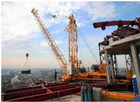
Ilustración 3.37 Grúa Derrick para el desmontaje de grúas
