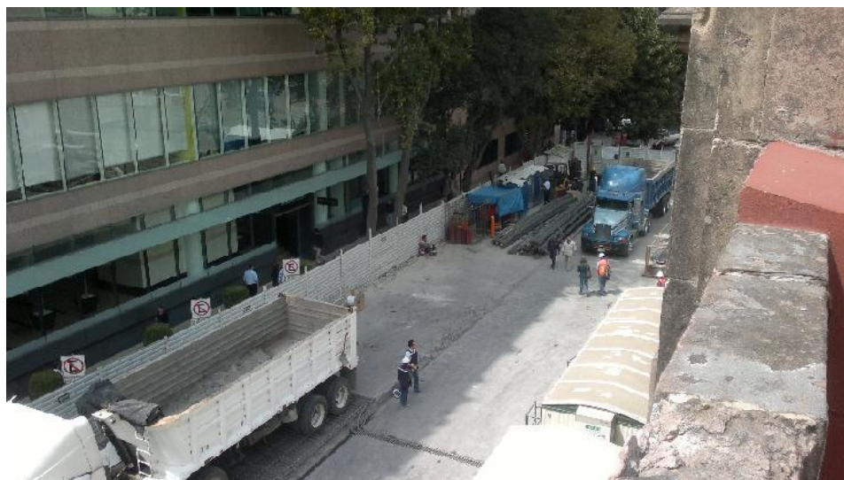
Ilustración 3. 15 Zona de descarga
