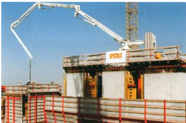
Ilustración 2.18 y 2.19 Cimbra auto-trepante con pluma colocadora de concreto
