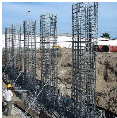
Ilustración 2.35 Armado de columna, con tensores
