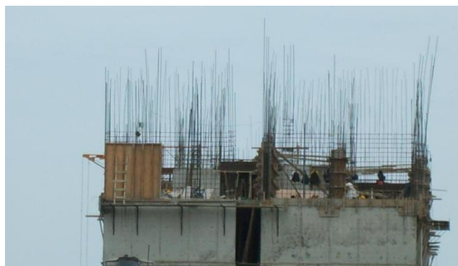
Ilustración 2.36 Armado de muro
