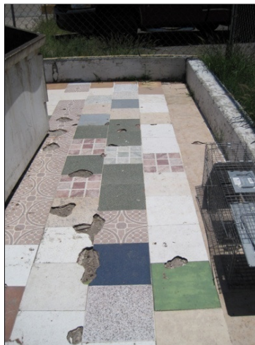
Figura 4.19 - Foto del área destinada al contenedor de residuos orgánicos.
