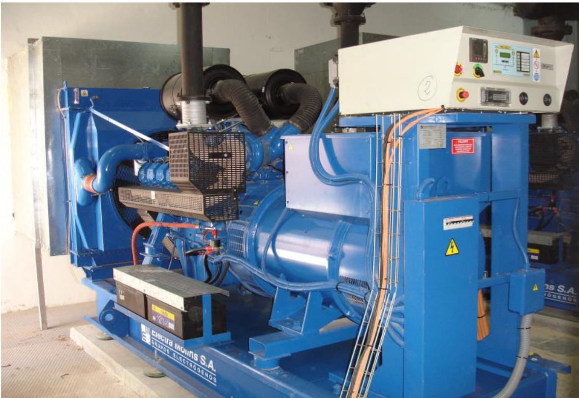
Figura 33.- Grupo electrógeno.
