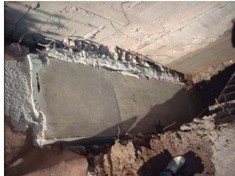
Imagen 6.2 Recimentación (vista en planta)
