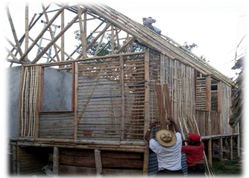
Casa realizada en bambú; Arq. Armando Rodríguez.
