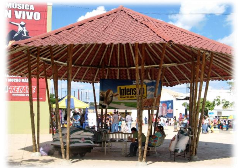
Estructura de bambú en la Feria de Xmatcuil, Yucatán.
