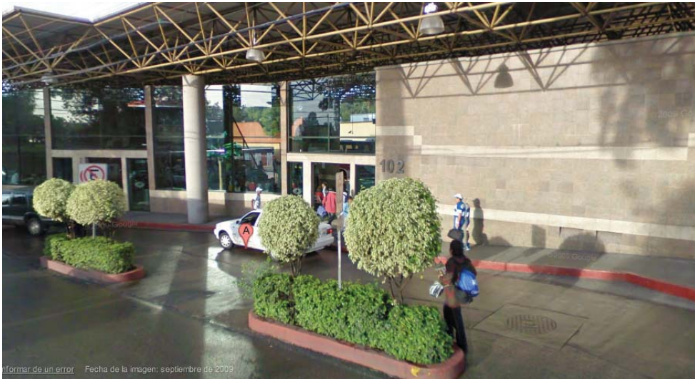
-Fig.7. El acceso a la Terminal de Autobuses y las bahías no tienen una dimensión necesaria para la necesidad de la misma; además de que no cuenta con las facilidades para las personas con capacidades diferentes.
