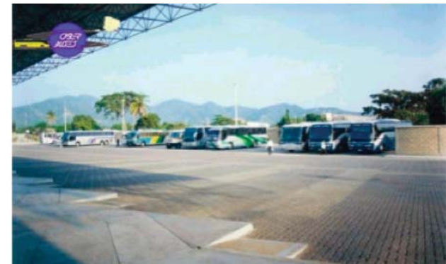
(Fig.2) Vista a los andenes y patio de maniobras de la central.
