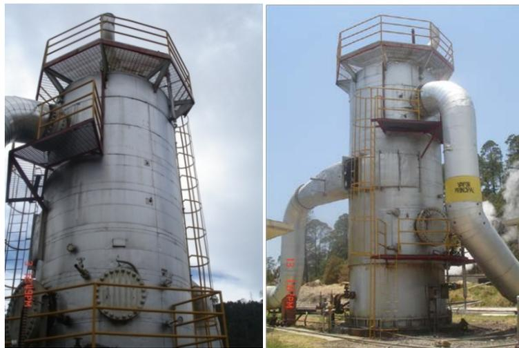
Figura 2. Separador de vapor de la Unidad 7.
