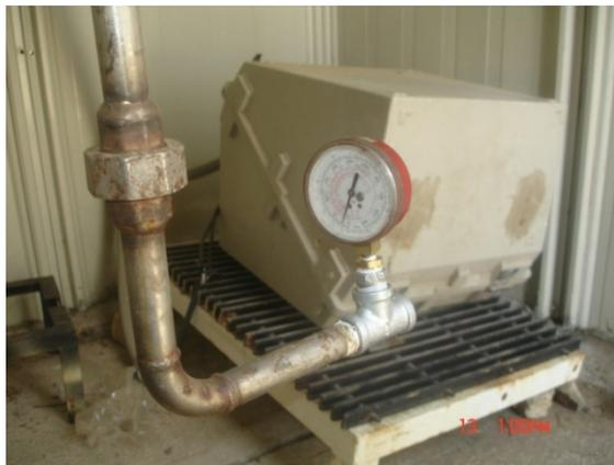
Figura 5. Montaje del manómetro. Fotografía del 13 de mayo del 2011.
