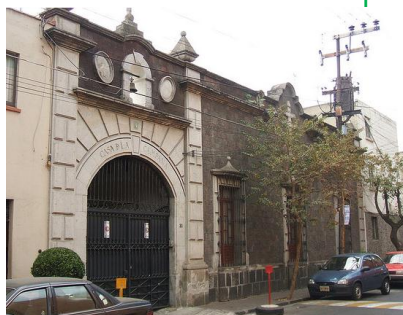
Casa de la campana
