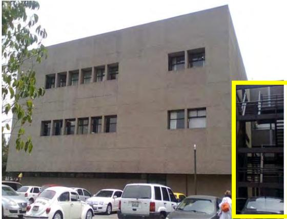
El color de la fachada es café, y ésta cuenta con una proporción 1 a 1 en vanos, predomina el macizo sobre el vano, el diseño de los vanos es abocinado para evitar una penetración solar profunda. El volumen es una forma geométrica simple y pura.
