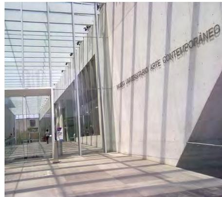
Del MUAC retomé algunos de sus elementos para el diseño del hospital, como los taludes invertidos de sus enormes ventanales que proyectan una sensación de transparencia, también me inspiré en sus muros de concreto blanco y liso así como en la inclinación de sus muros que genera corredores techados abiertos. Asimismo, me pareció notable y digno retomar el papel que juega la luz en el espacio de este edificio.
