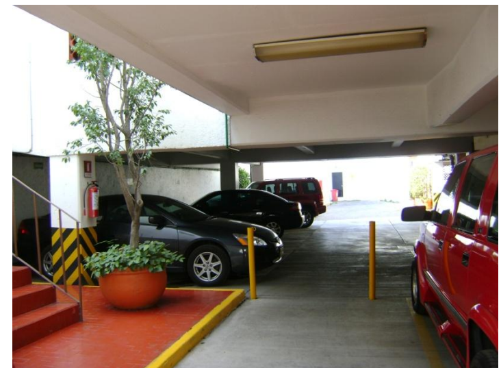
Imagen 38. Vista del tramo de estacionamiento subterráneo considerado para desarrollar un proyecto puntual.
