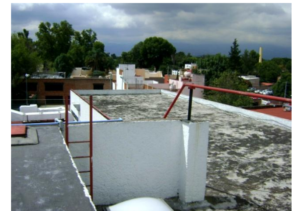
Imagen 13. Fotografías que ejemplifican las metas de los recorridos: la primera: identificación del Hospital (APEC). La segunda: pedir autorización y compañía para examinar todos los espacios del Hospital.
