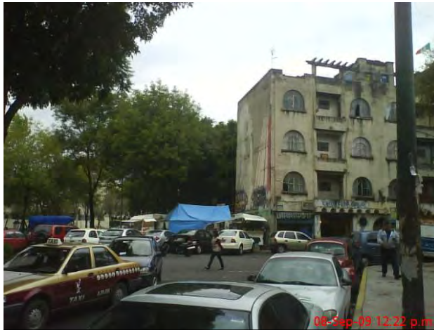
VISTA DESDE LA CALLE DE SOTO, AQUÍ SE PUEDE OBSERVAR LA CARENCIA DE REMATE EN LA ESQUINA LO CUAL GENERA UNA RUPTURA UN EL FRENTE URBANO DE REFORMA
