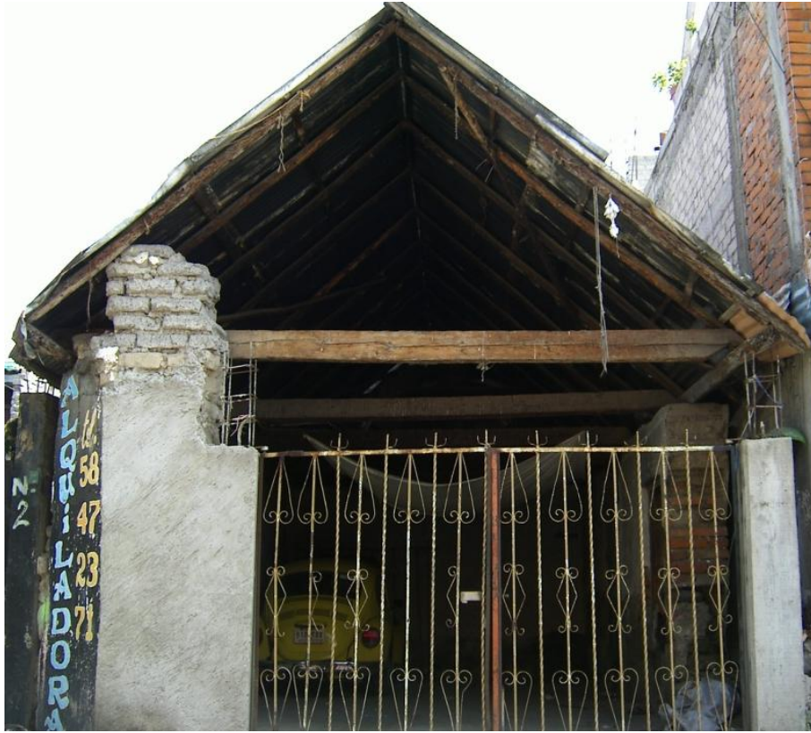
Imagen 4. Antigua casa de adobe, hoy utilizada como cochera. Se aprecia el interior de la antigua vivienda 69 .
