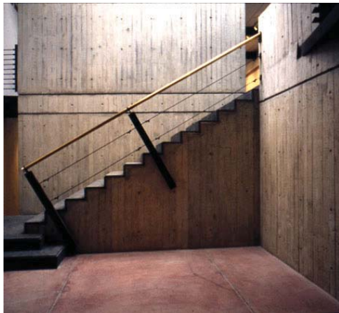
Escalera de concreto aparente
