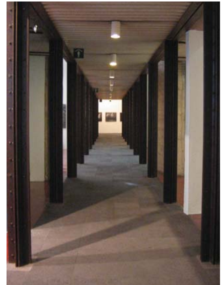
Columnas de puente
