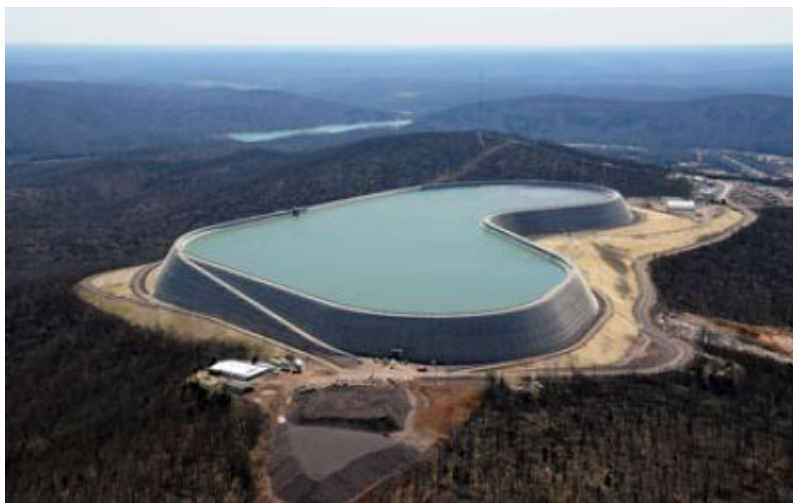
Figura 3.3. Reconstrucción de la planta hidroeléctrica Taum Sauk.
