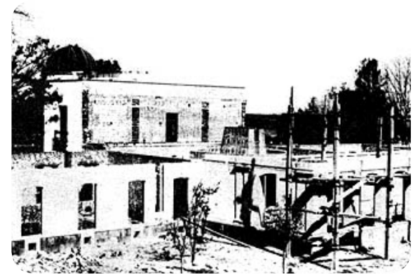
Construcción del edificio del Observatorio Astronómico Nacional en Tacubaya.
