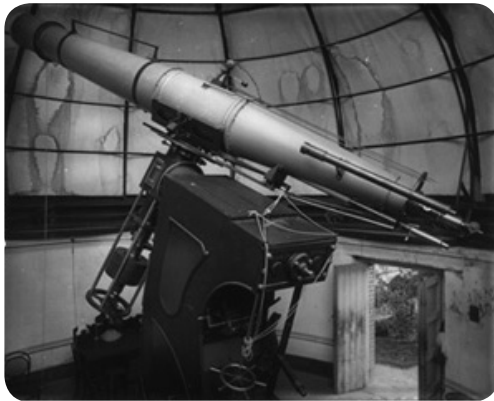
Telescopio refractor de 5 metros de distancia focal y lente de 38 centímetros de diámetro. En 1891 se encontraba instalado provisionalmente en los jardines del ex arzobispado de Tacubaya.
