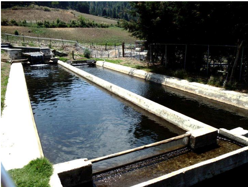
Figura 2.3 Estanques de concreto
