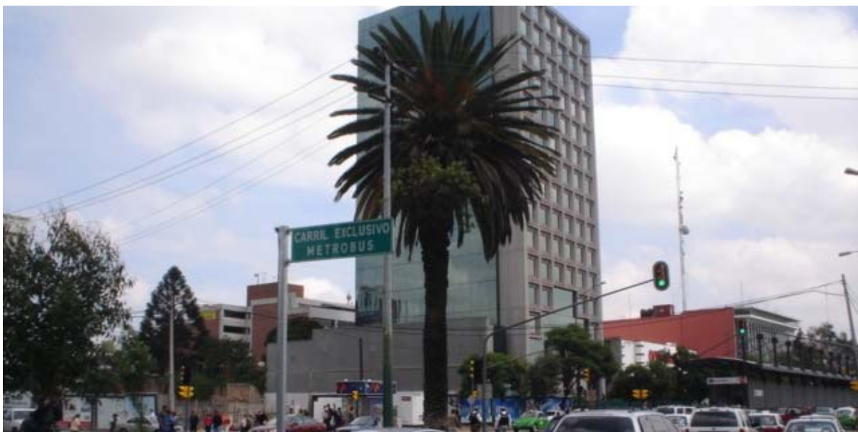
Fotografía del terreno desde la esquina de Av. Insurgentes y Loreto, donde se aprecia además el edificio del Consejo de la Judicatura, con el cual colinda y que tiene una altura de quince niveles, asimismo se observa el mobiliario urbano (infraestructura, metrobús), la vegetación existente, así como parte del afluente vehicular que prevalece en esta avenida.
