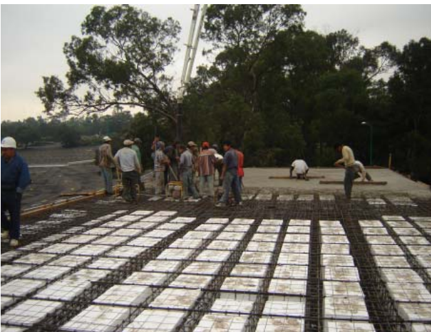
17. Colado de losa, nivel azotea.
