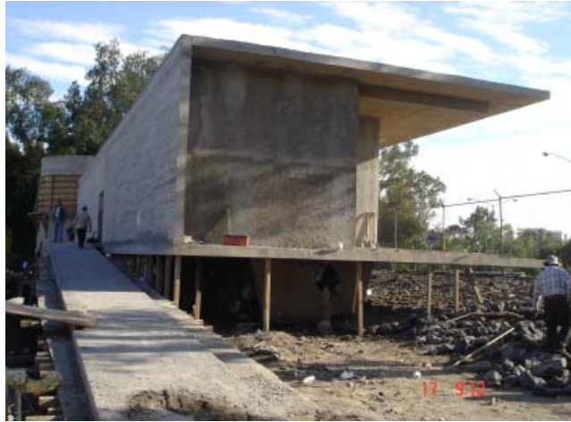
20. Muro y losas de concreto descimbradas.
