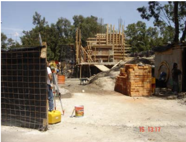
11. Armado de cartelas y muro concreto, nivel tienda.
