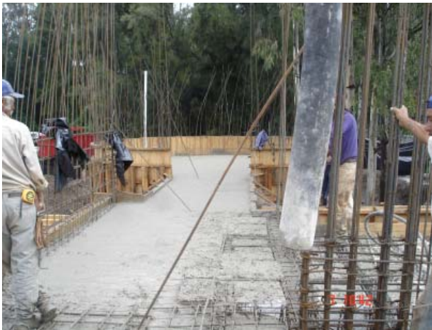
9. Colado de losa en tienda, puente y cilindro, nivel tienda.
