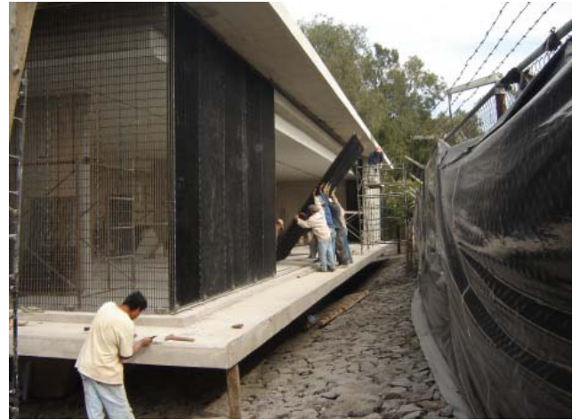
26. Colocación de láminas de rejilla irving para proteger fachada.
