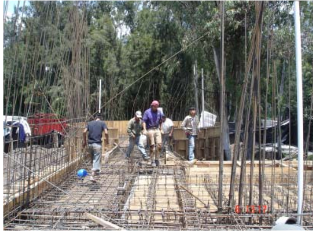
8. Armado de losa, nivel tienda.
