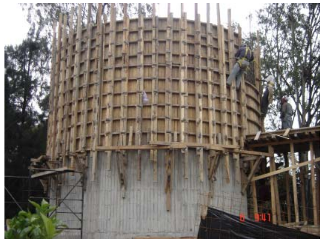
18. Armado de muros de cilindro.
