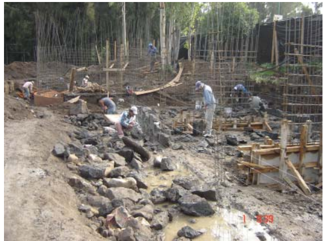
4. Desplante de muros de piedra, bodega.
