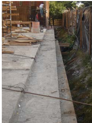
12. Losa colada, nivel tienda.
