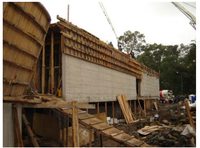
16. Colado de losa nivel azotea y muro de concreto.
