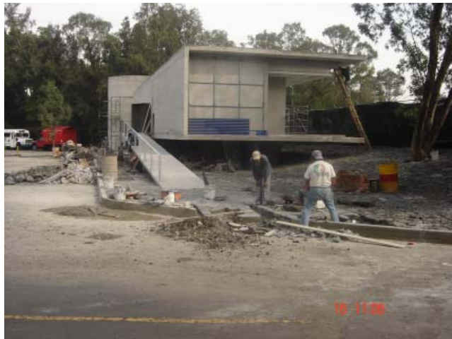
24. Trabajos exterior; bastidor y muestras de lámina en fachada.
