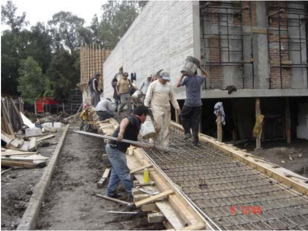
19. Colado de rampa de acceso.
