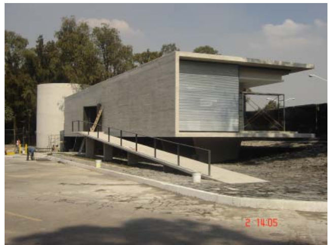
28. Lámina en fachada y exteriores.
