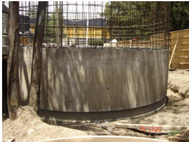
10. Avance en colado de muro de cilindro.
