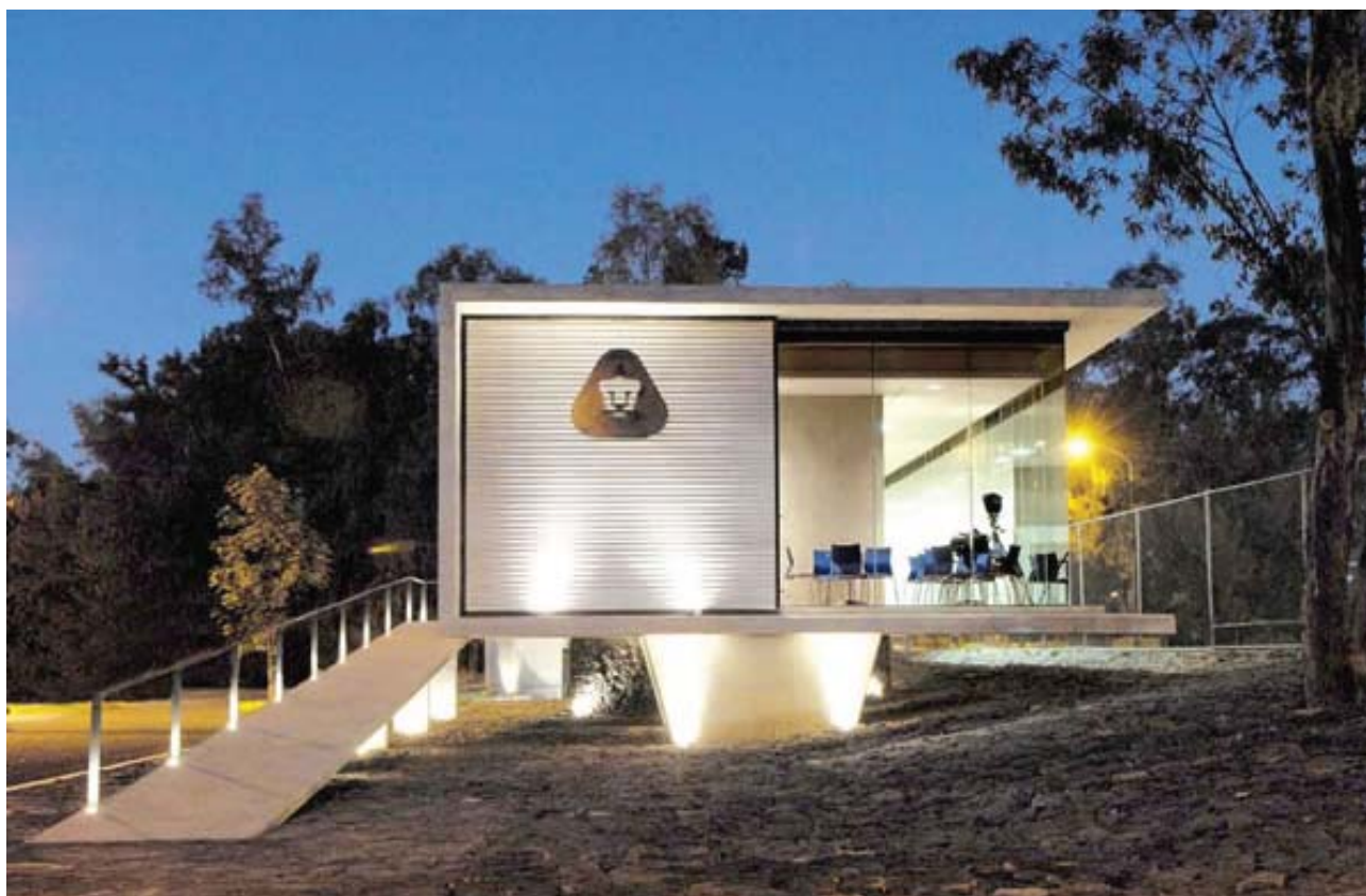
Vistas exteriores, fotos: CAFEL Ingeniería.
