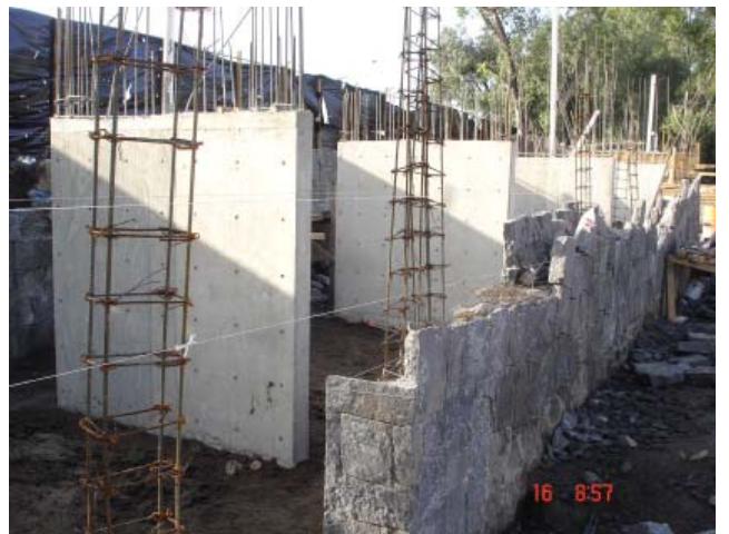
6. Cartelas coladas y muros de piedra, bodega.
