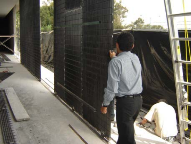
25. Prueba de rejilla irving para proteger fachada. Arq. Leal.
