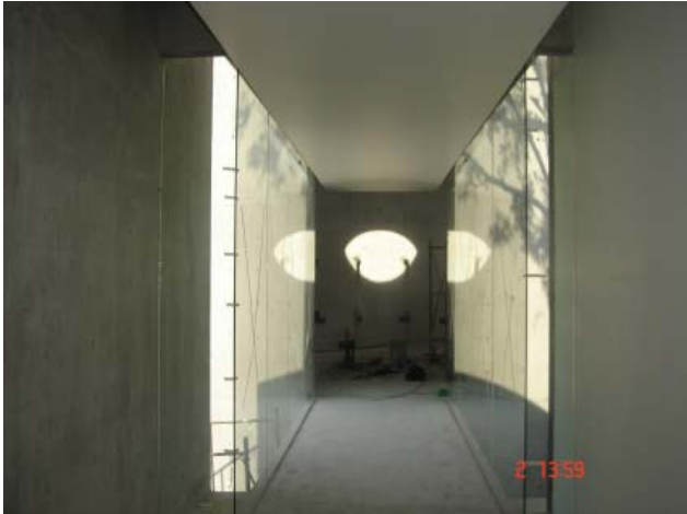
31. Vidrios y plafones en puente.
