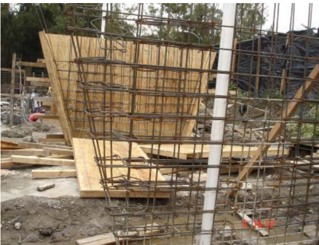
5. Armado y cimbra de cartelas, sótano.
