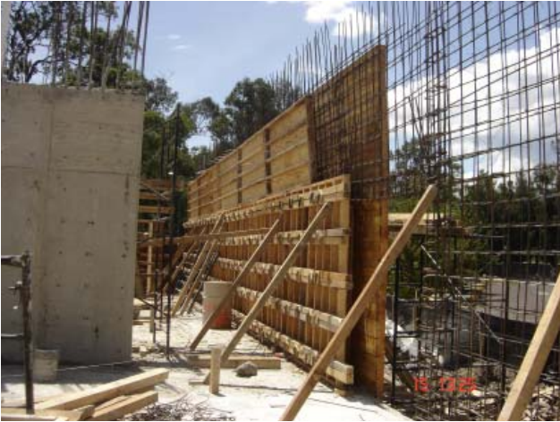
13. Cartela colada, cimbra y armado muro concreto, nivel tienda.
