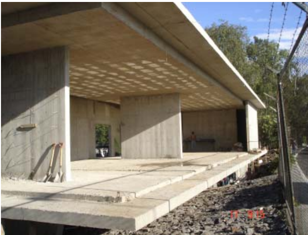
21. Muro y losas y cartelas de concreto descimbradas.
