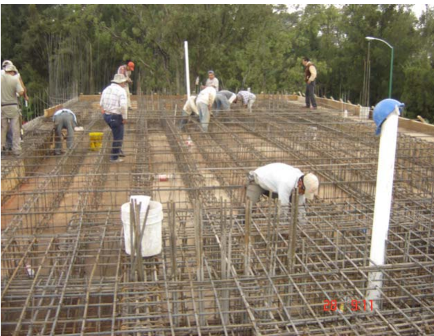
15. Armado de losa, nivel azotea.
