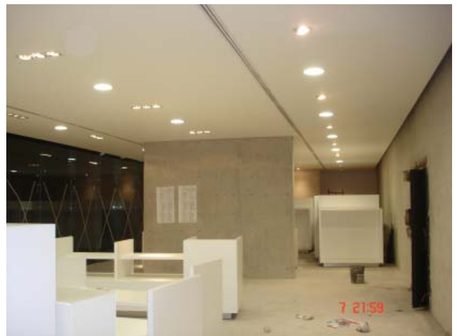
30. Plafones, luminarias y mobiliario interior.
