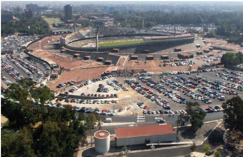
Foto aérea. Tienda Puma y Estadio, 2007. Tomada por Cafel Ingeniería
