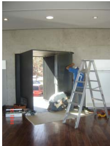
36. Colocación de puerta de vidrio de acceso.
