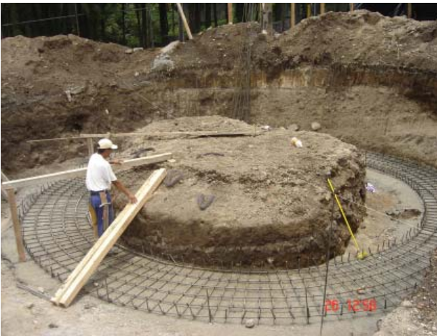
3. Cimentación del cilindro.
