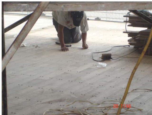
34. Colocación de piso de madera.
