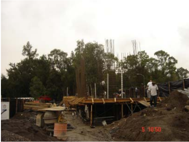
7. Armado y cimbra para losa, nivel tienda.
