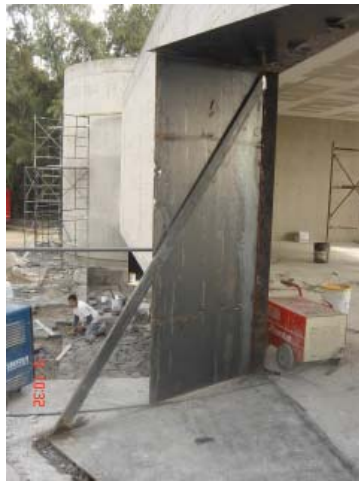
22. Herrería de la "caja" de acceso, en proceso.
