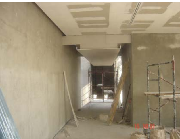
27. Trabajo de plafones en tienda y puente.
