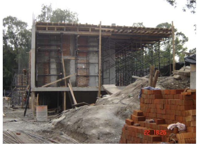
14. Muro colado, avance en muros y cimbra losa de nivel azotea.
