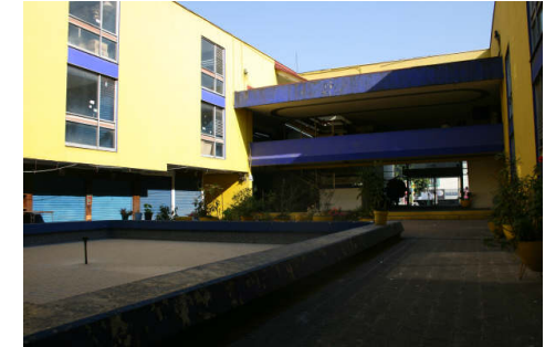
Img. 1 Vista del patio interior
