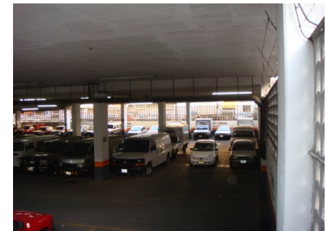
Img. 2 Vista del estacionamiento y columnas
