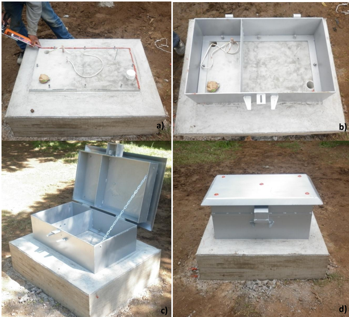
Figura III.16. Ensamble de la caja metálica
