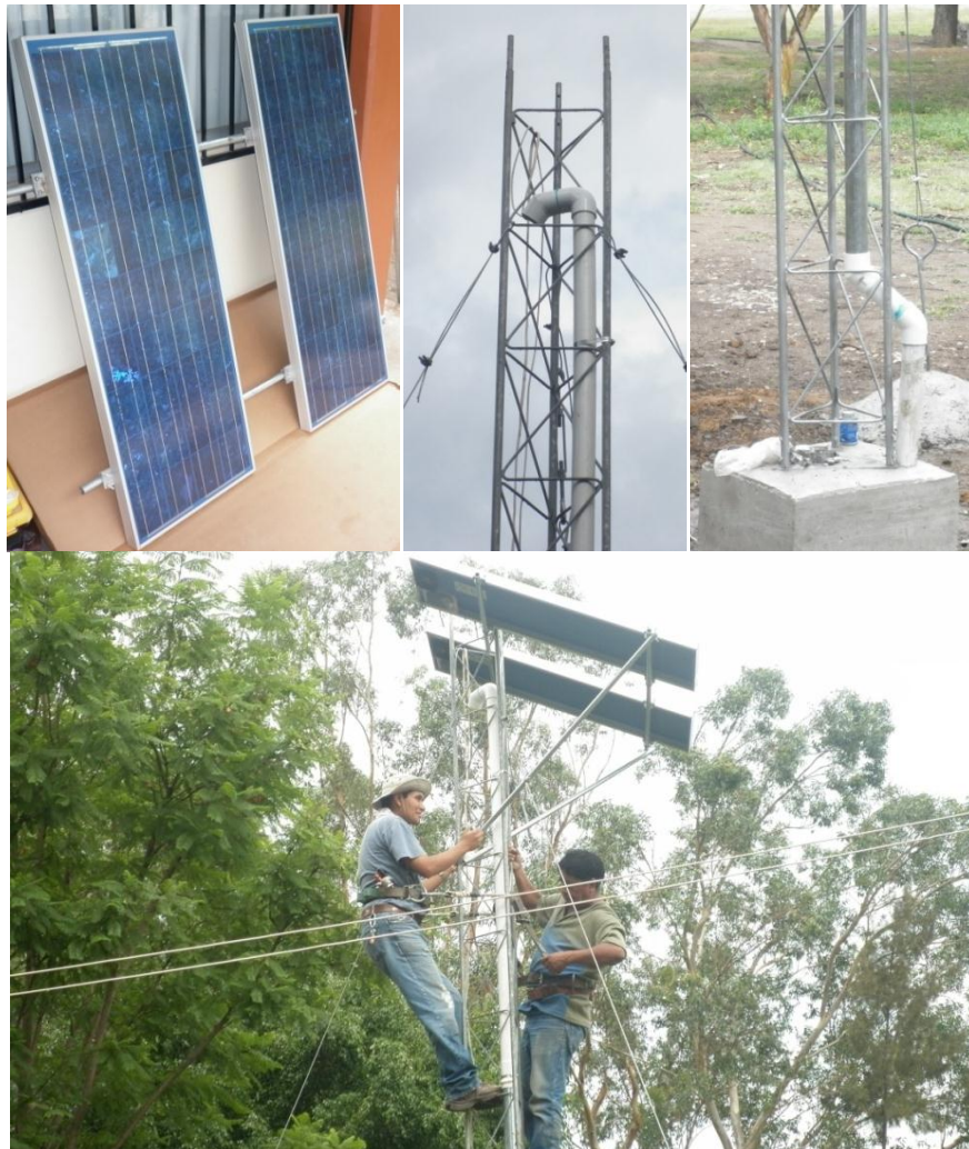
Figura III.20. Colocación de celdas solares
