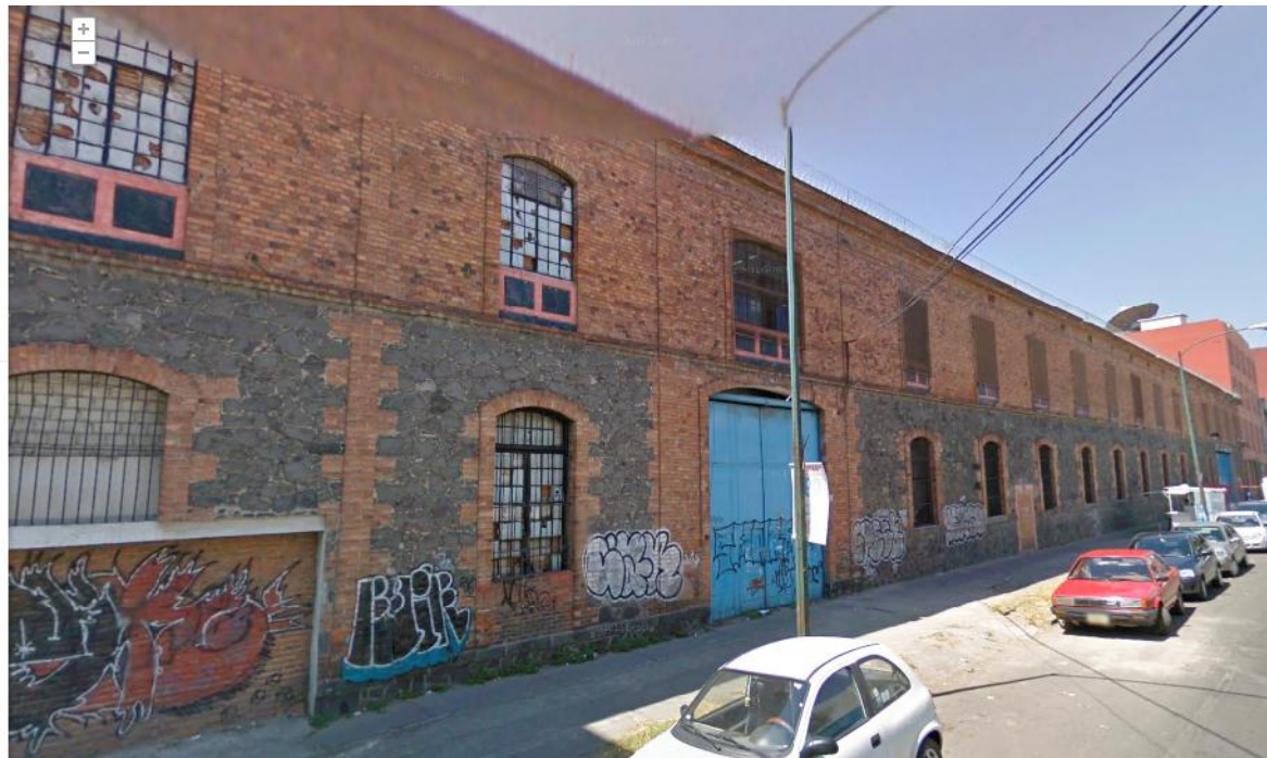
Bodega en la Colonia Obrera en inmueble de valor arquitectónico
