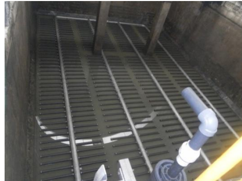
Figura AI.8 Arreglo de difusores tubulares.
