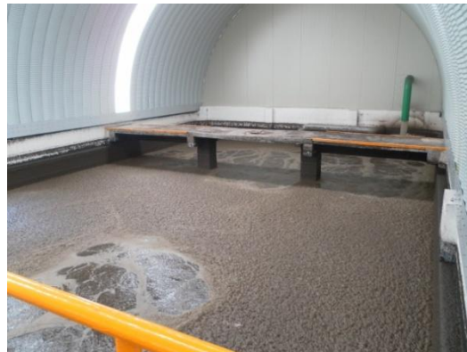
Figura AI.9 Tanque de aireación.
