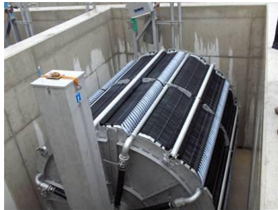
Figura 3.6 Unidad de membranas.
