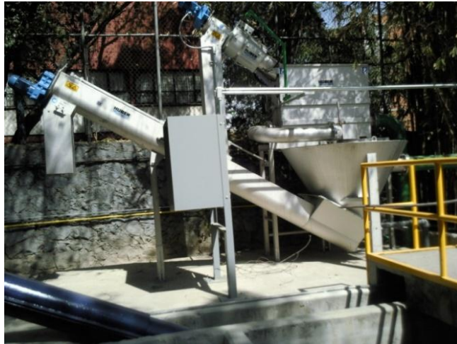
Figura AI.2 Desarenador tipo Vortex
