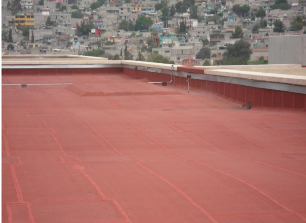
Foto 54 Terminado de impermeabilización
