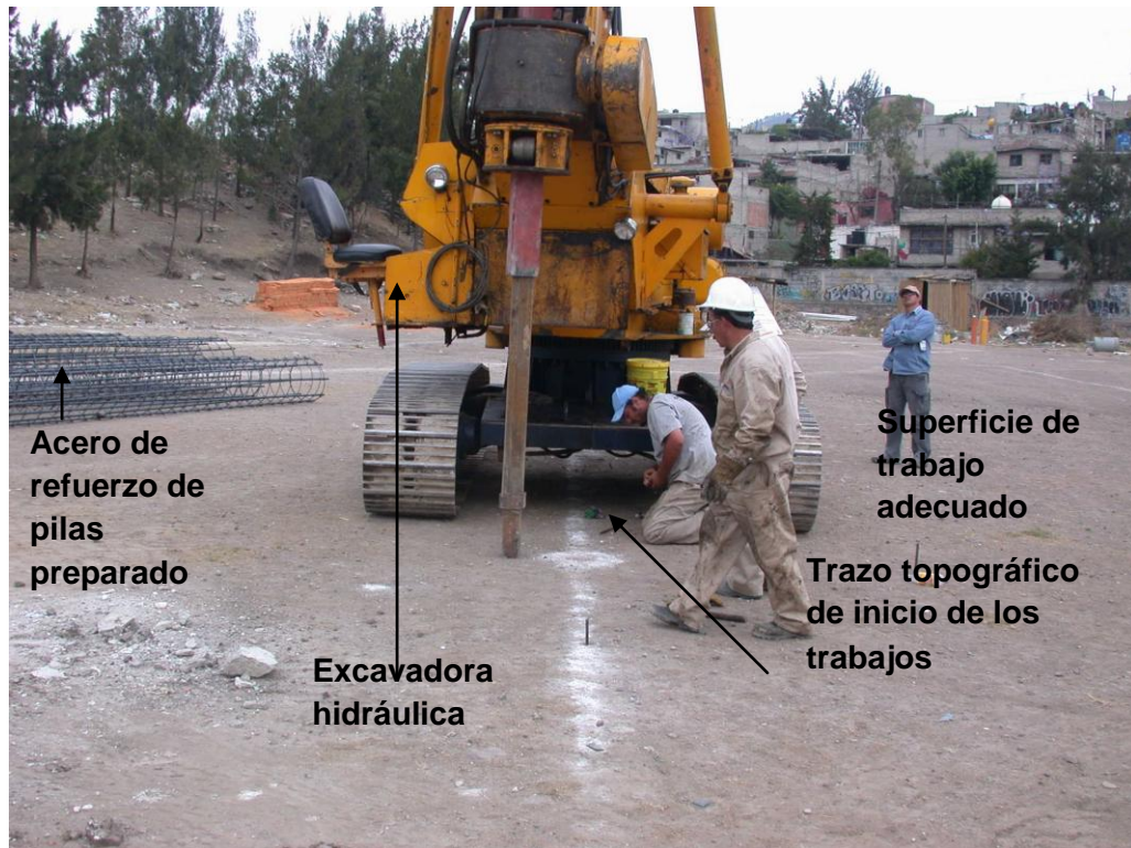
Foto 7 Preparación del sitio para el inicio de la perforación del edificio 1
