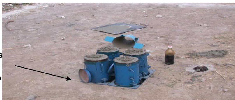
Foto 32 Muestra en cilindros para prueba de resistencia de concreto
