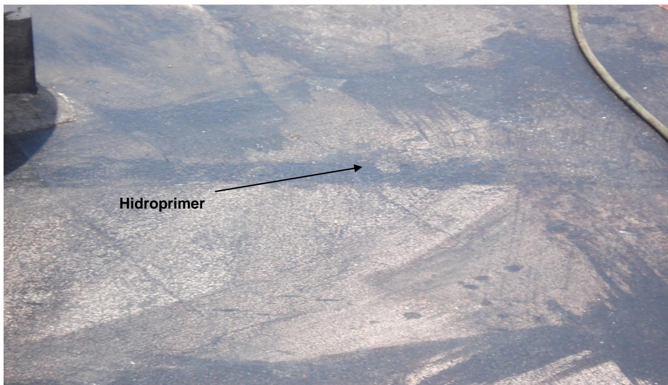
Foto 51 Tendido de material hidroprimer para colocación de prefabricado
