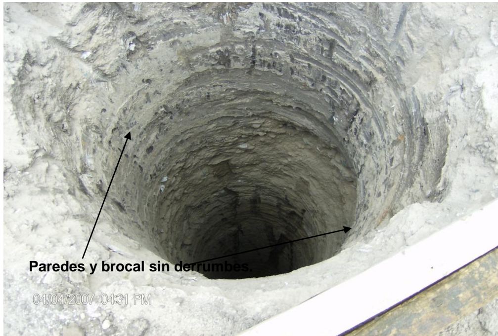
Foto 10 Condiciones físicas de la perforación terminada
