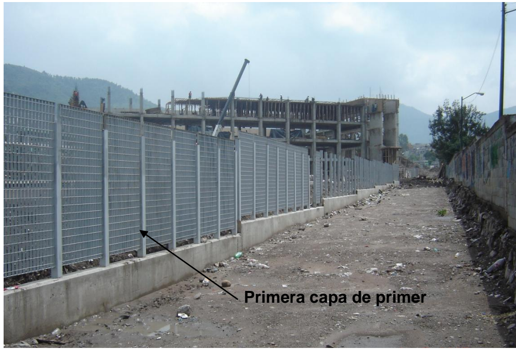
Foto 6 Aplicación de primera capa de primer
