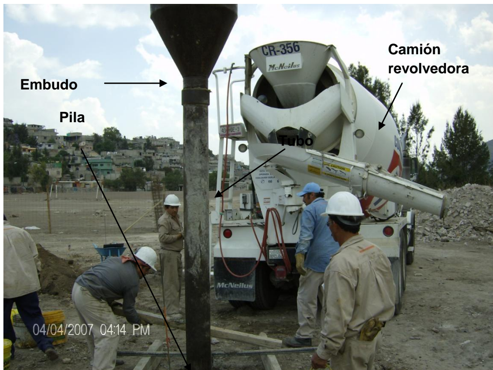
Foto 14 Se muestra Método Tremie
