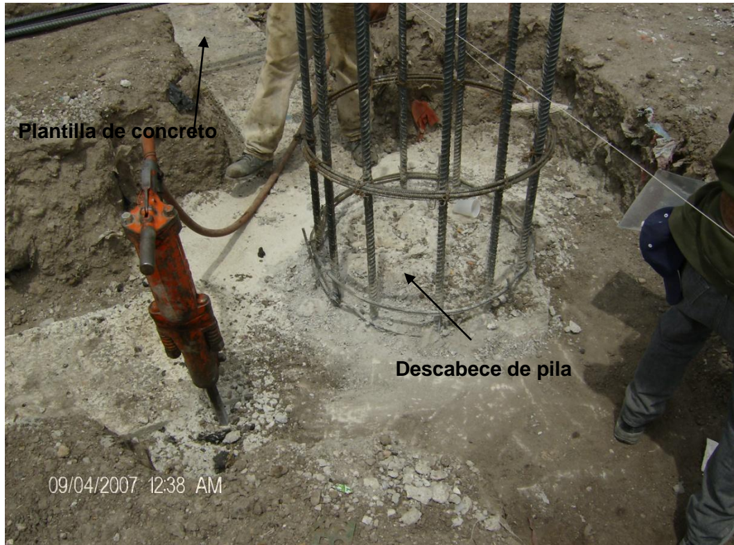
Foto 16 Descabece mecánico de pila y colocación de plantilla de concreto
