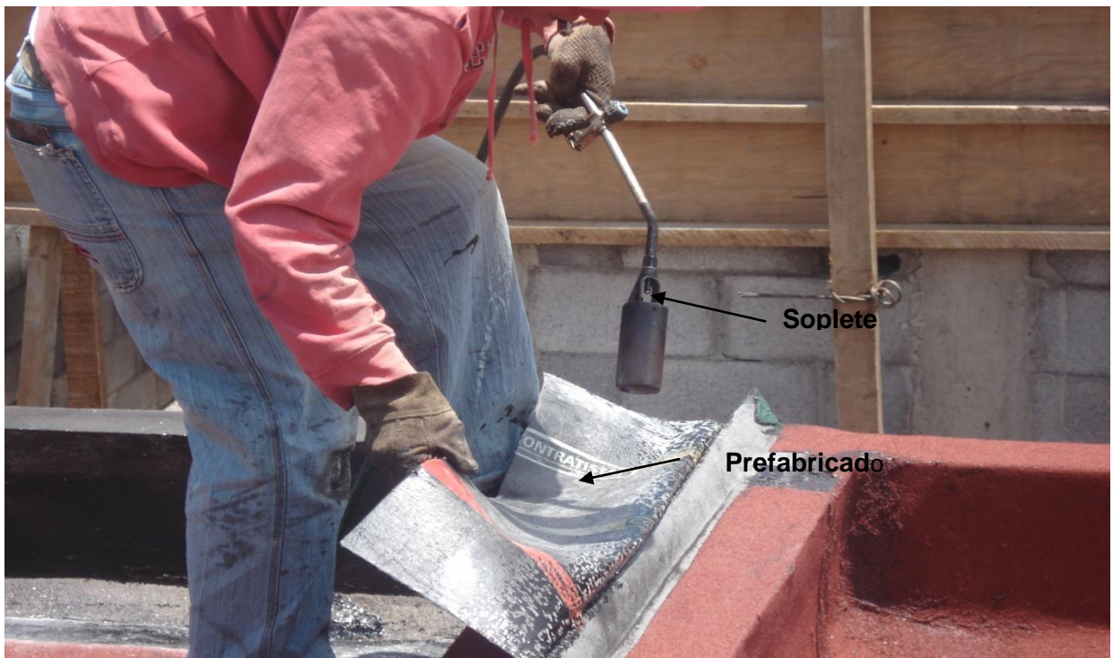
Foto 52 Colocación de material prefabricado con soplete
