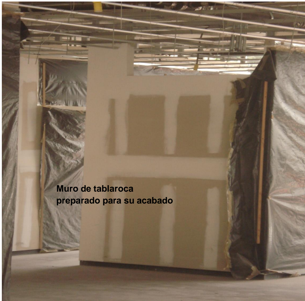
Foto 50 Muro de tablaroca terminado para acabado final
