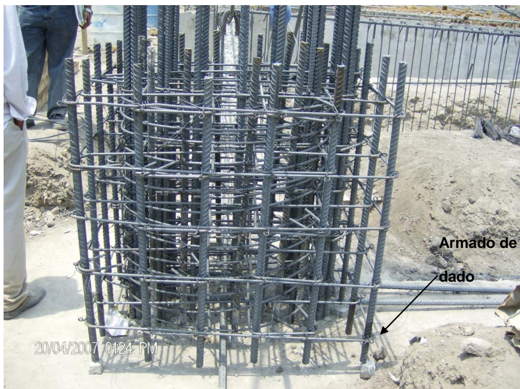
Foto 18 Armado de dado tipo
