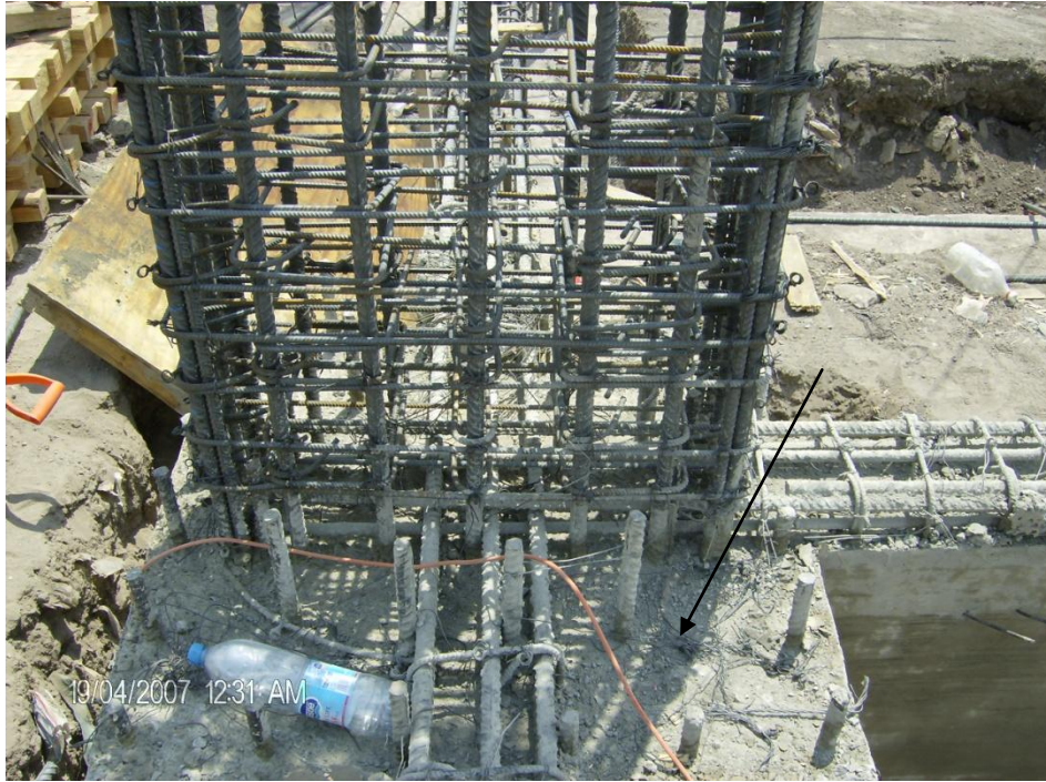
Foto 24 Descimbrado de trabe de liga y dado de cimentación
