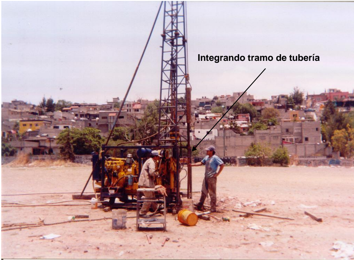
Foto 3 Realización de la segunda prueba de penetración estándar
