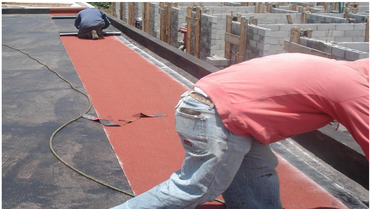
Foto 53 Tendido de impermeabilizante
