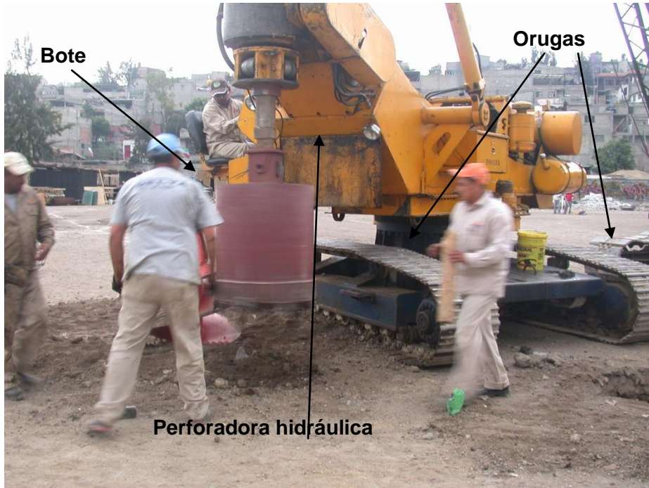
Foto 9 Trabajos de perforación con bote
