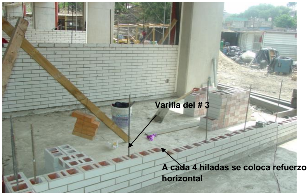
Foto 40 Muro de block Santa Julia (preparación para refuerzo horizontal)
