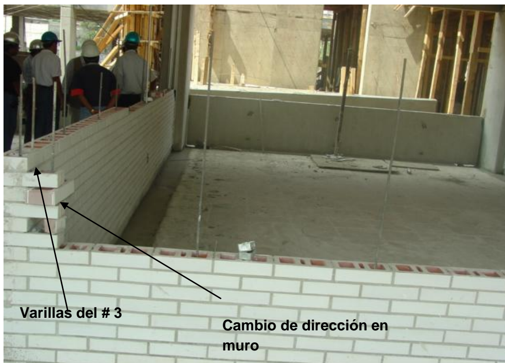
Foto 41 Aquí se muestra cambio de dirección y varillas ahogadas del # 3
