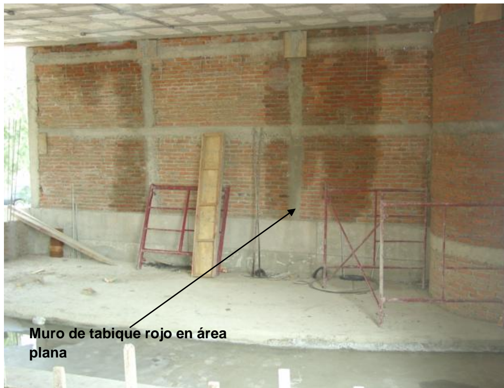
Foto 39 Muro de tabique rojo en área plana
