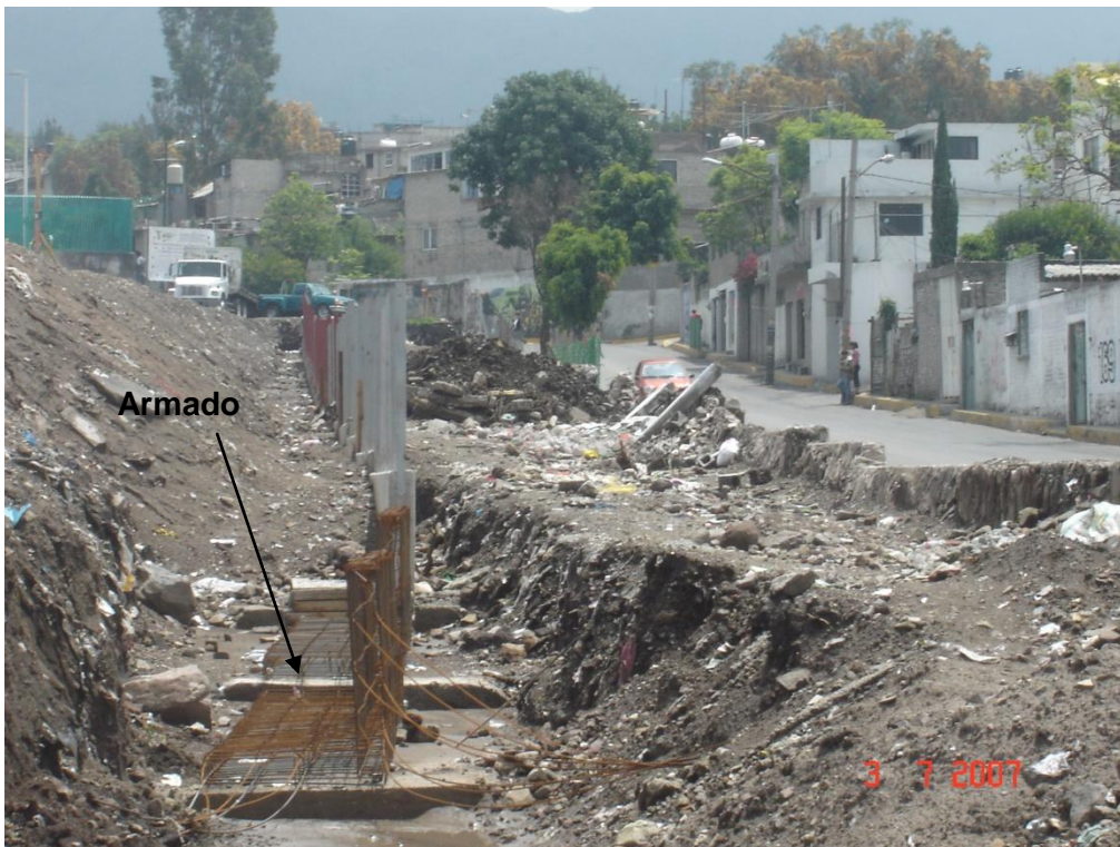
Foto 1 Armado de zapata reja perimetral
