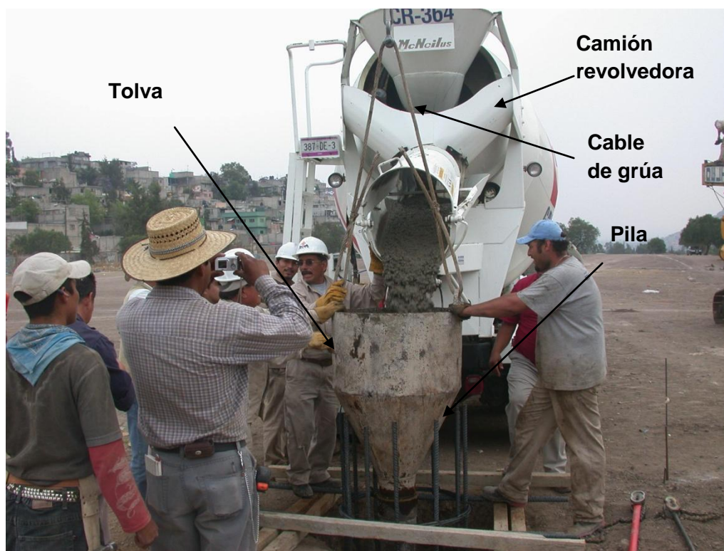
Foto 15 Se observa vaciado del camión revolvedora a la tolva
