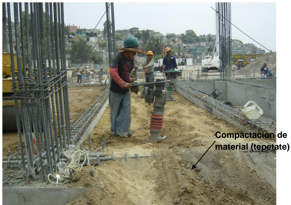
Foto 23 Compactación de material inerte (tepetate)
