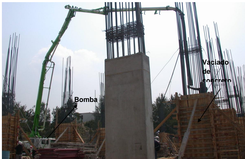
Foto 33 Colado de columnas con tubería para concreto
