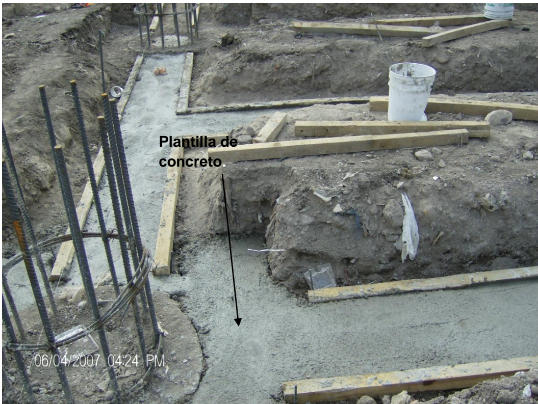
Foto 17 Suministro y colocado de plantilla de concreto
