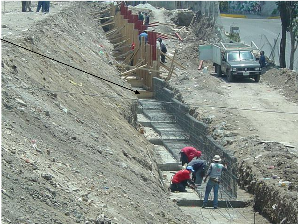
Foto 2 Colocación de celotex en junta
