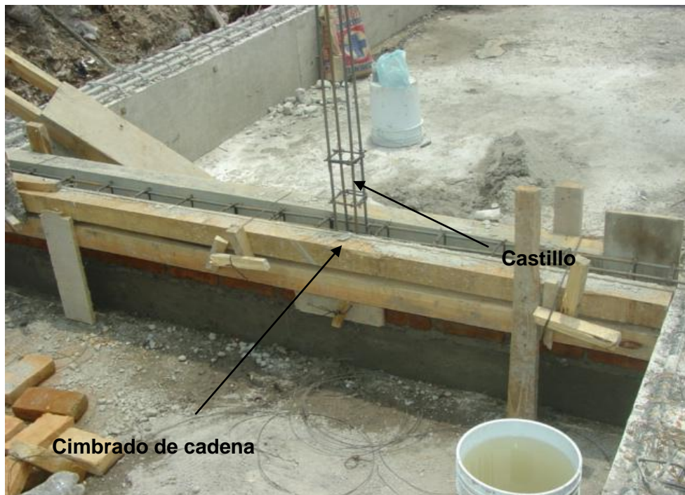
Foto 44 Cimbrado de cadenas
