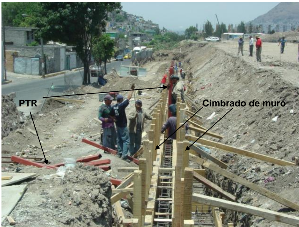
Foto 4 Colocación de PTR y cimbrado de muro
