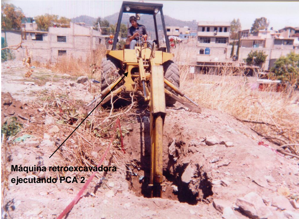
Foto 1 Inicio de pozo a cielo abierto dos (PCA 2)
