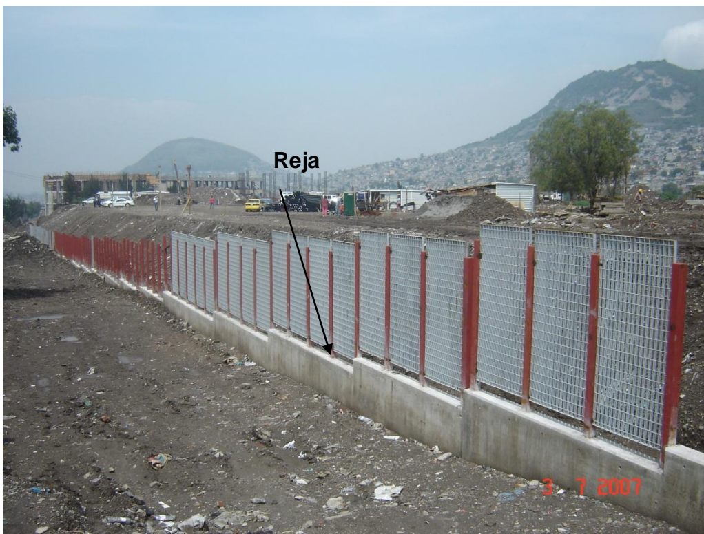
Foto 5 Colocación de reja tipo Irving
