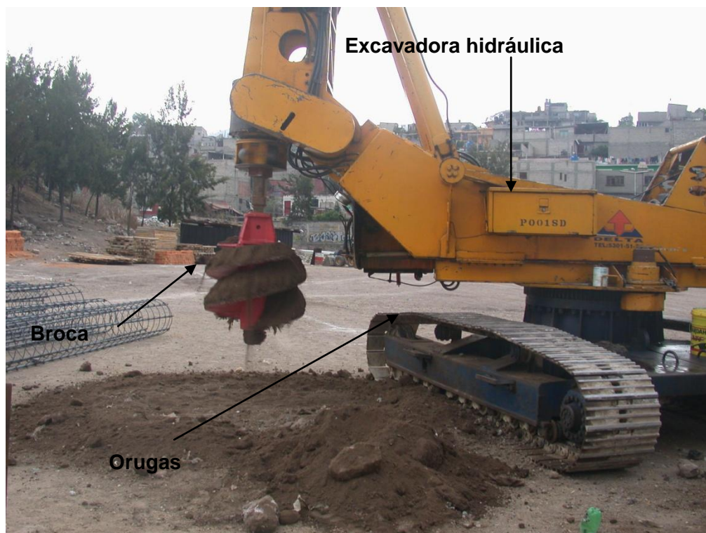
Foto 8 Inicio de los trabajos de perforación
