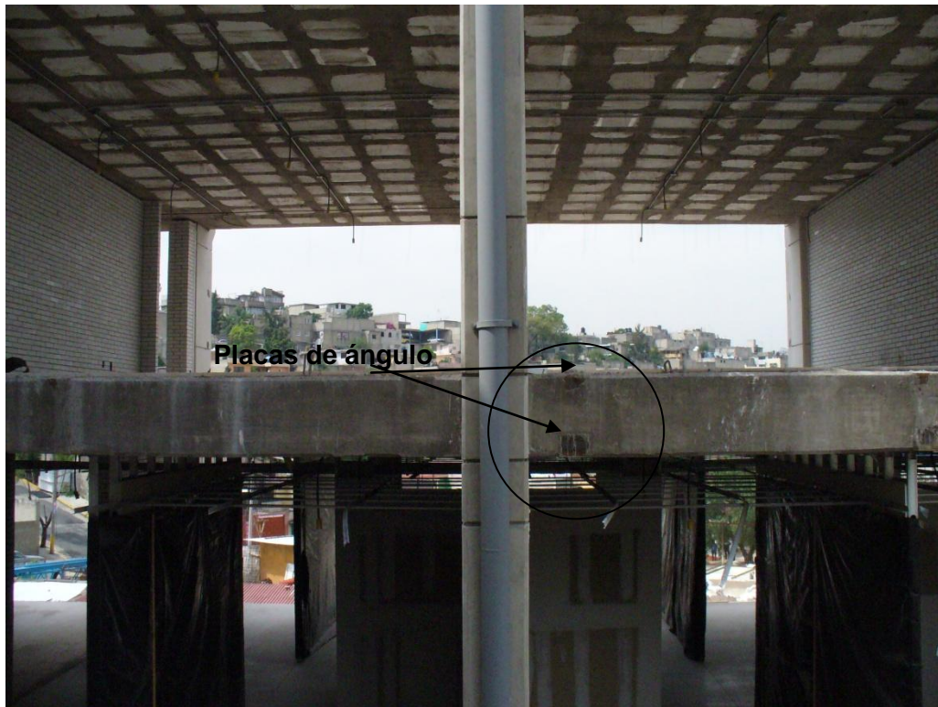
Foto 29 Colocación de placas de ángulo para prefabricados
