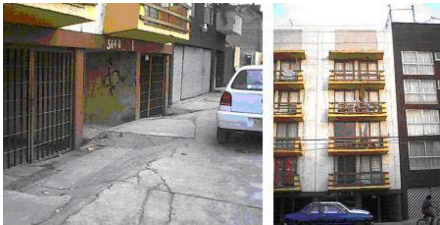
Foto 6. Ejemplo de falla en el estado de servicio de un edificio en la ciudad de México.
