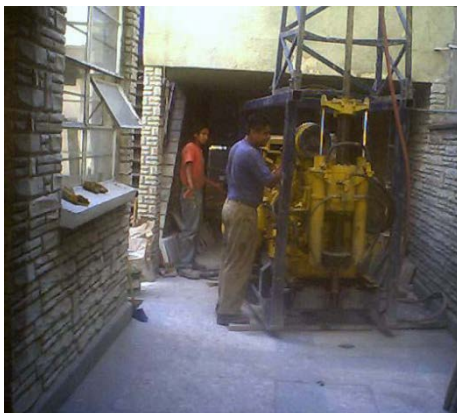
Foto 4. Vista del equipo de perforación y ubicación del sondeo SCE-1.
