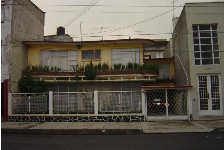
Apreciamos la construcción anterior, la cual se encontraba descuidada.
