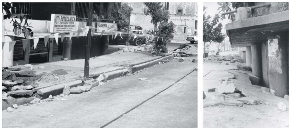
Foto 7. Falla local de la cimentación de un edificio en la ciudad de México en el sismo del 19 de septiembre de 1985.
