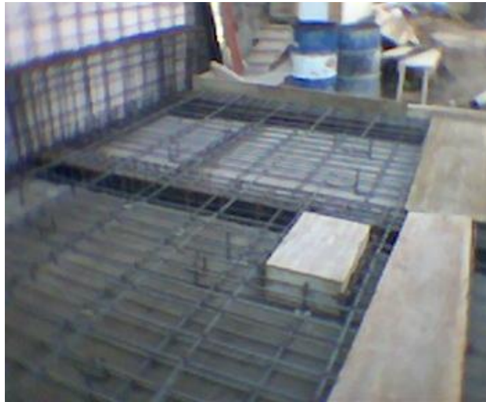
Las preparaciones para la losa corrida de concreto armado de 20 cm.
