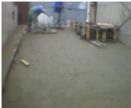
La foto muestra la rampa para vehículos con la pendiente máxima de 15%, con su guarnición lateral, separando el acceso peatonal.
