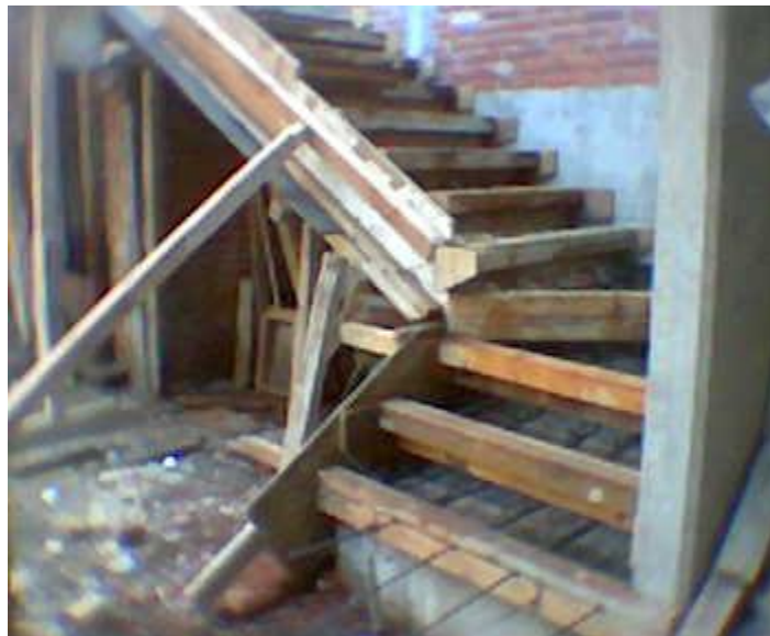
Cimbra y armado para colar los escalones de la escalera.
