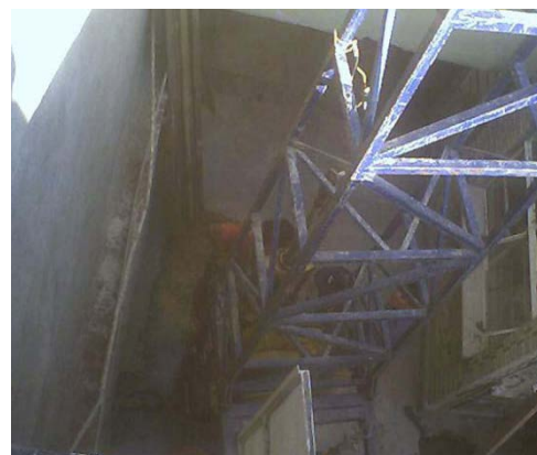
Foto 5. Vista superior del equipo de perforación en el lugar.
