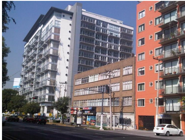
Las nuevas y modernas edificaciones de la colonia Narvarte sobresalen en forma y tamaño respecto a las anteriores.
