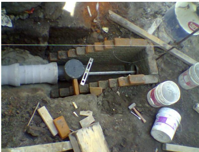
En la foto se muestra que el diámetro del albañal es de 20 cm. con una pendiente del 2%. Se observa también la elaboración de un registro forjado a base de tabique referente al Art. 160 del Reglamento.
