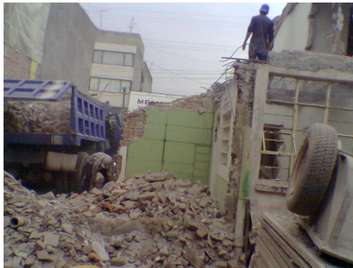
Fotos de la demolición de la casa existente en el predio.
