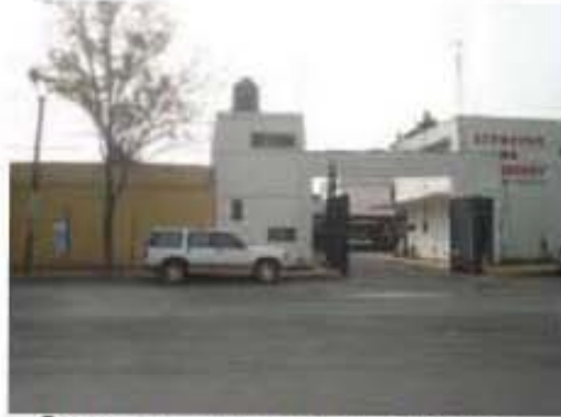
2 Estación de bomberos Tláhuac
