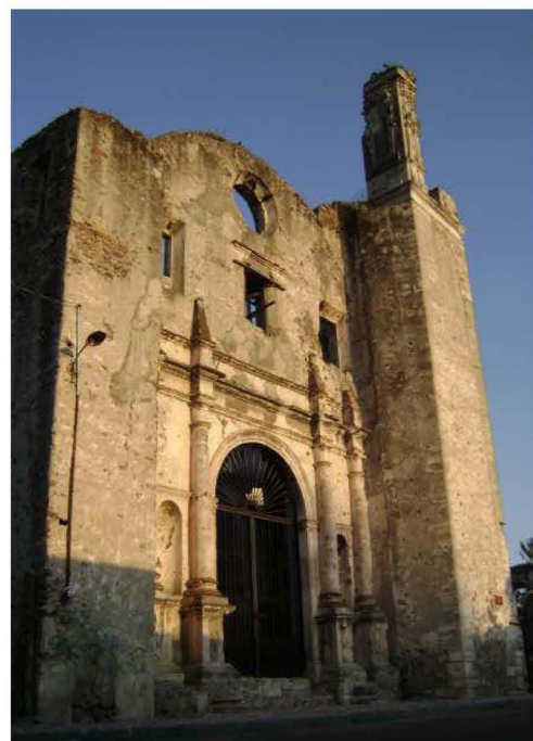
7. Fachada Principal -Poniente
