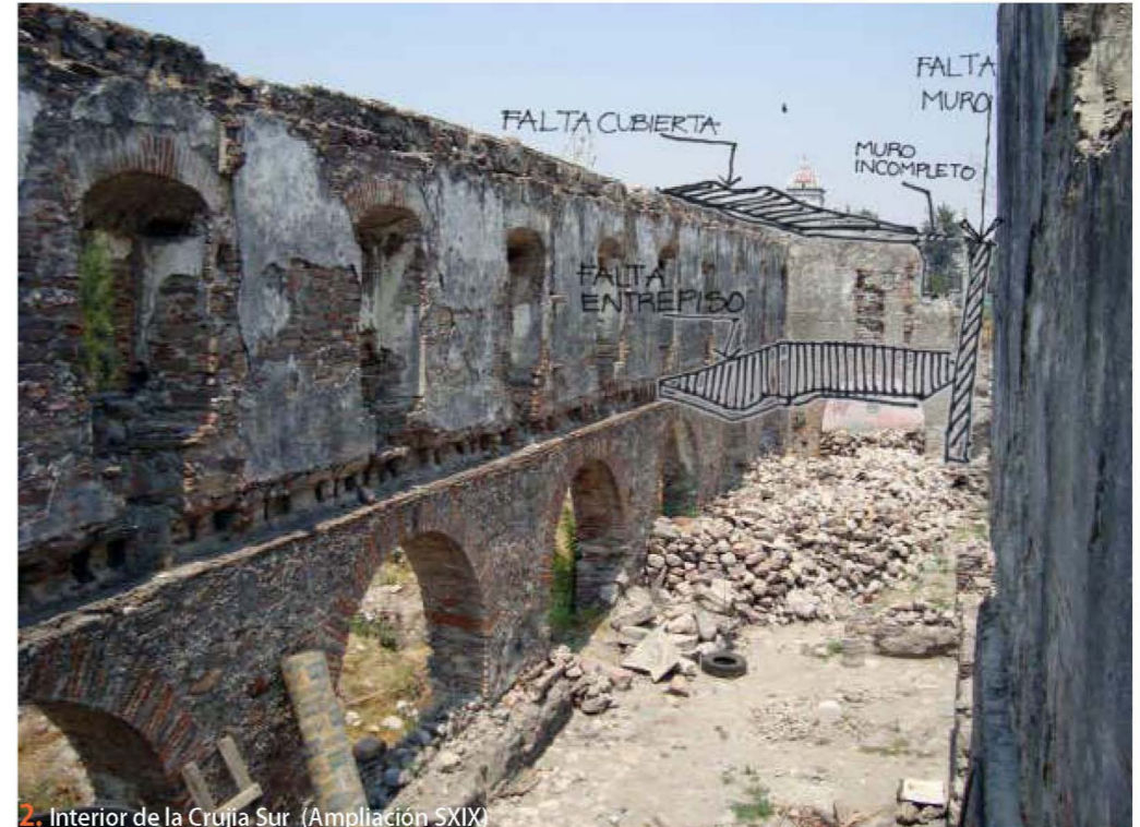
2. Interior de la Crujía Sur (Ampliación SXIX)
