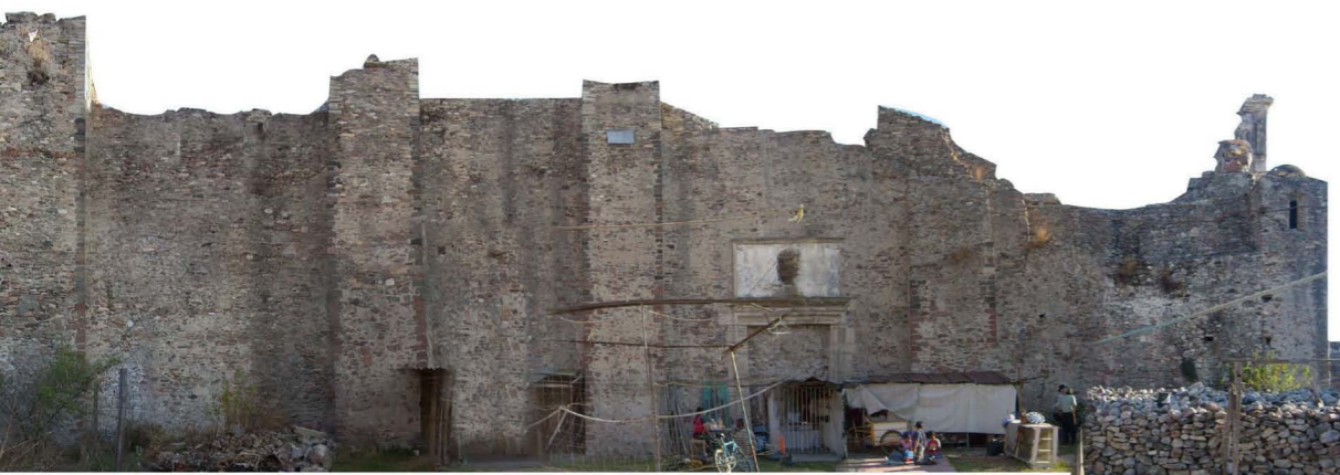
5. Muro Norte del Templo
