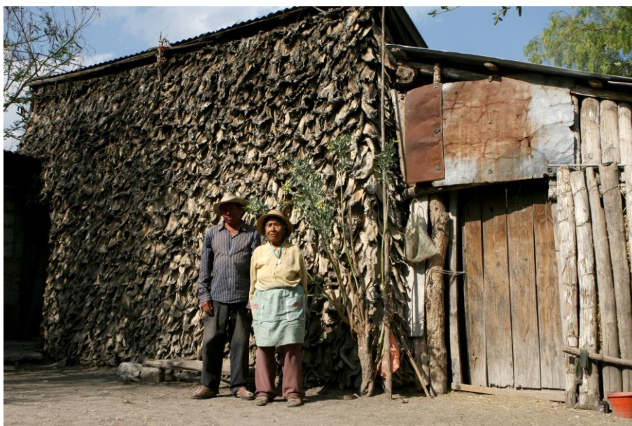
Mati y Jovita junto a su cocina construida con pencas de maguey. Foto: Fernanda Robinson, San Miguel Tlasintla, Hgo. 2011.
