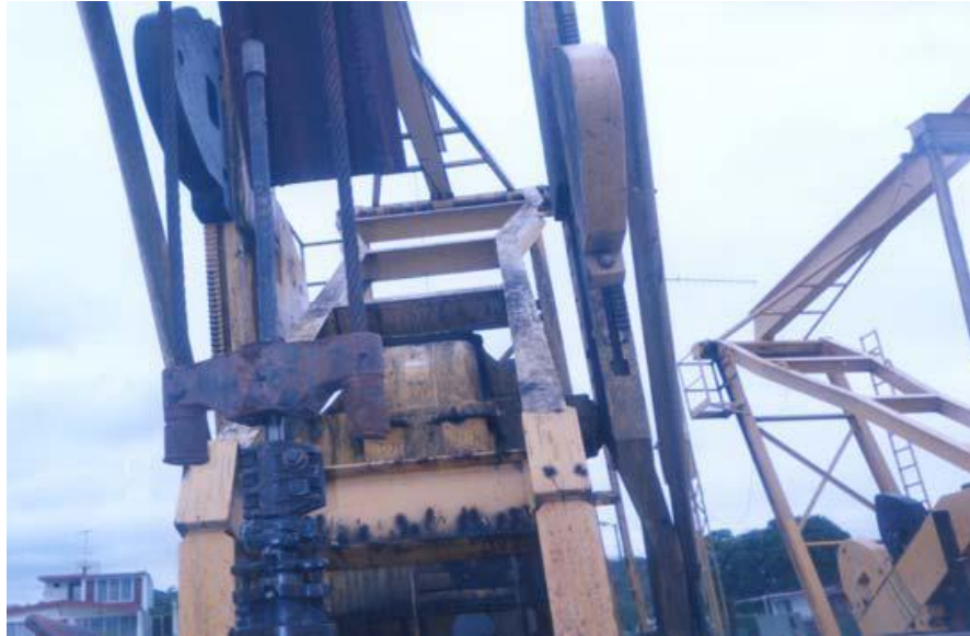
Figura 3.20. Colocación de la unidad de bombeo mecánico en punto muerto.
