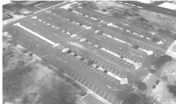
Figura. 14 cap.III diagnostico del pavimento por observación FES Aragón fuente: google earth
