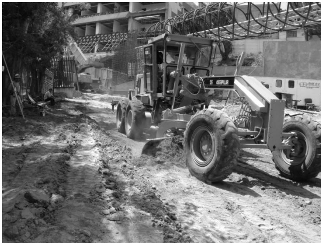
Figura. 16 cap. V Descripción de actividades motoconformadora nivelando y conformando material
