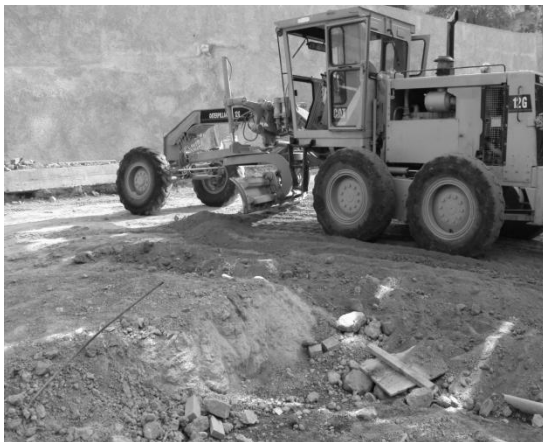
Figura. 24 cap. V Descripción de actividades motoconformadora extendiendo material
