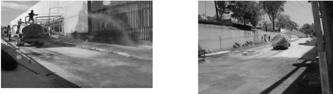
Figura. 28 cap. V Descripción de actividades humedecer el área de tendido
