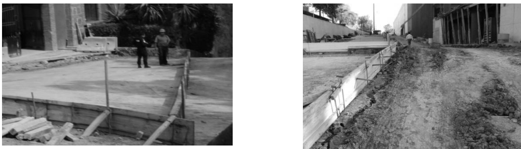
(Figura. 29 cap. V Descripción de actividades encofrado y colocado de juntas de construcción
