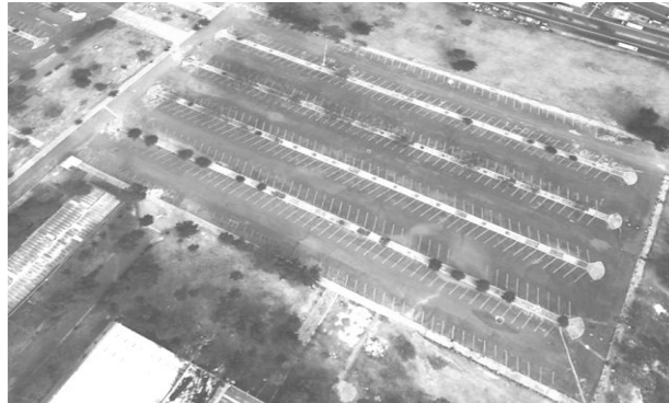
Figura. 56 cap.III diagnostico del pavimento por observación FES Aragón fuente: google earth
