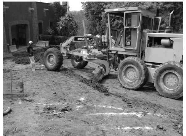
Figura. 24 cap. V Descripción de actividades motoconformadora extendiendo material
