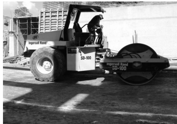
Figura. 19 cap. V Descripción de actividades compactación con rodillo
