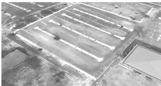
Figura. 84 cap.III diagnostico del pavimento por observación FES Aragón fuente: google earth
