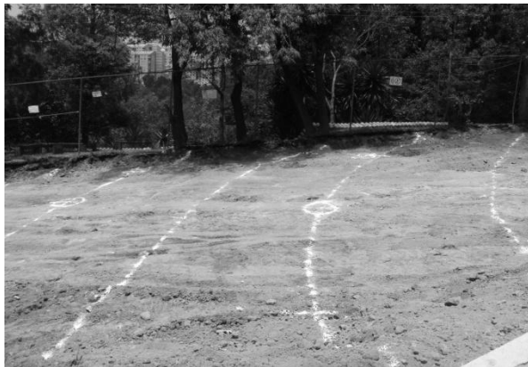
(Figura. 11 cap. V Descripción de actividades proceso de cadenamiento de sección natural
