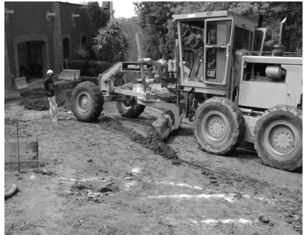
Figura. 15 cap. V Descripción de actividades diferencias entre material suelto y material conformado
