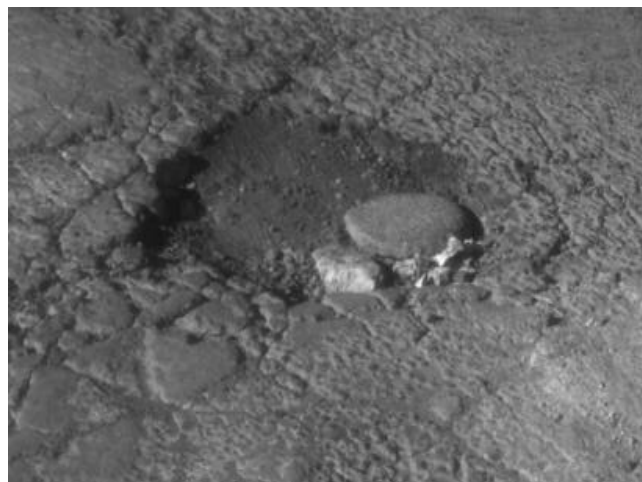
Figura. 10 cap.III tipos de fallas por observación baches estacionamiento de las FES Aragón
