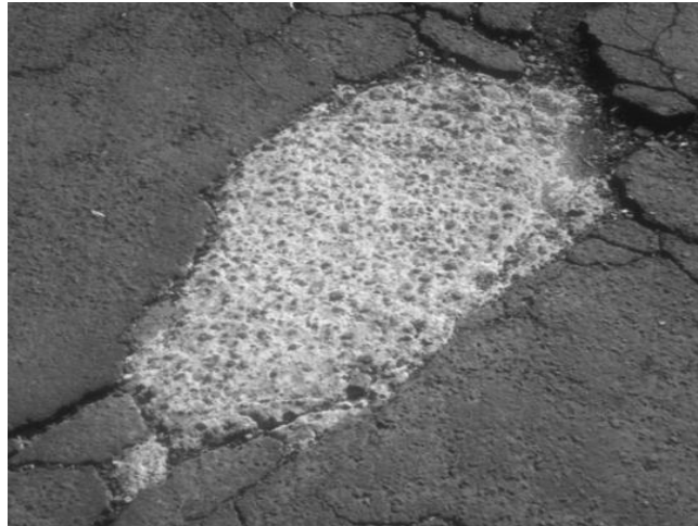
Figura. 11 cap.III tipos de fallas por observación ojos de pescado estacionamiento de las FES Aragón
