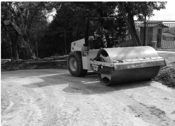
Figura. 19 cap. V Descripción de actividades compactación con rodillo
