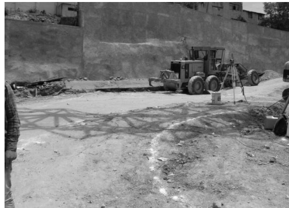
(Figura. 11 cap. V Descripción de actividades proceso de cadenamiento de sección natural
