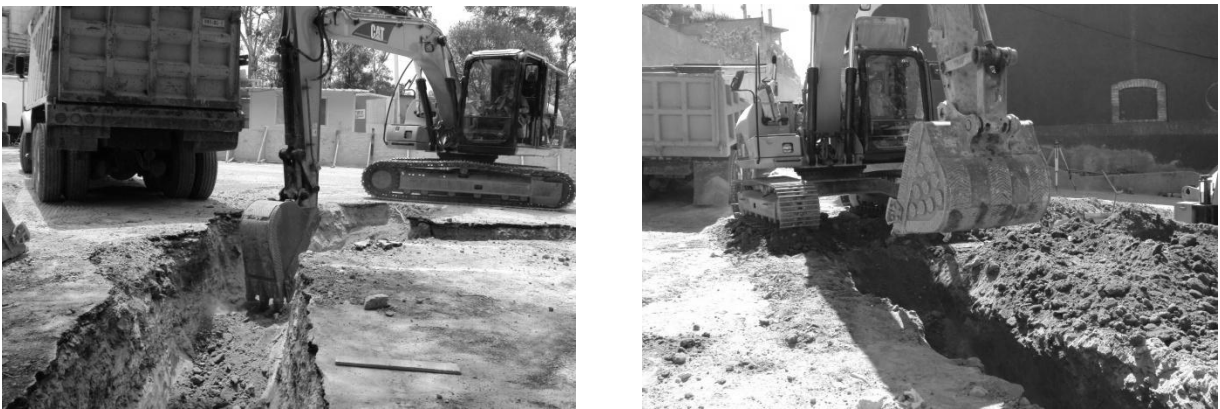
(Figura. 13 cap. V Descripción de actividades corte por medios mecánicos
