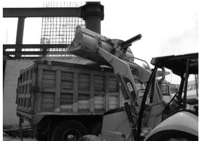
(Figura. 14 cap. V Descripción de actividades tipos de acarreo
