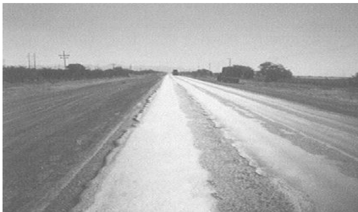
Figura. 6 cap.III tipos de fallas imagen de desplazamiento en zona de frenado
