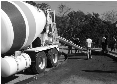
Figura 31 cap. V Descripción de actividades encofrado y colocado de juntas de construcción
