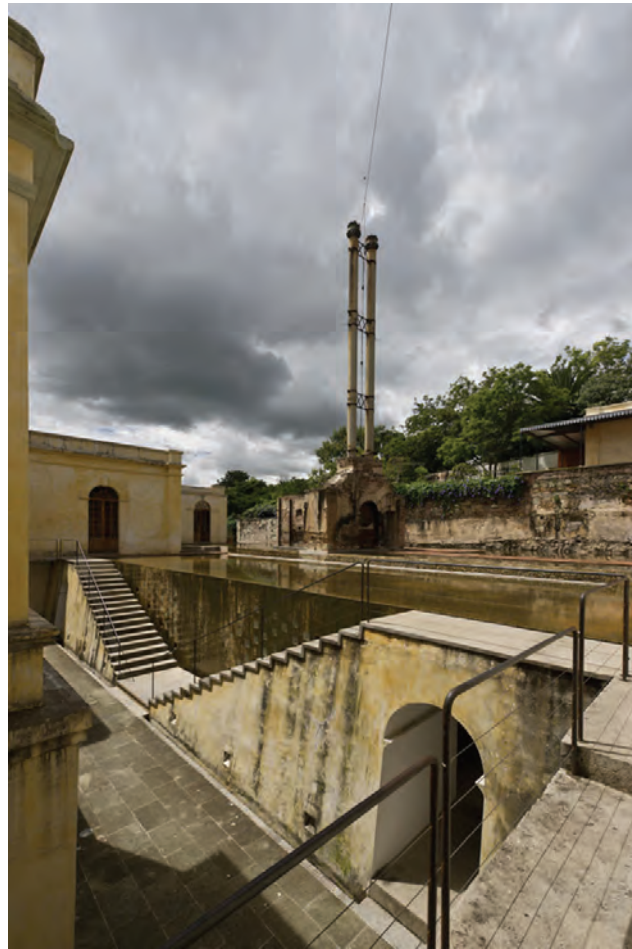
[26] En los muros de las áreas exteriores se conservó la pátina existente, y sólo en algunas zonas se reintegraron los aplanados con pintura a base de cal. Foto: http://www.arquine.com/television/centro-cultural-san-pablo-casa-oaxaca/
