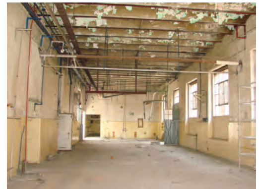
[42] Vista interior del Edificio A
