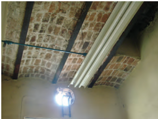
[41] Bóveda catalana. Edificio A
