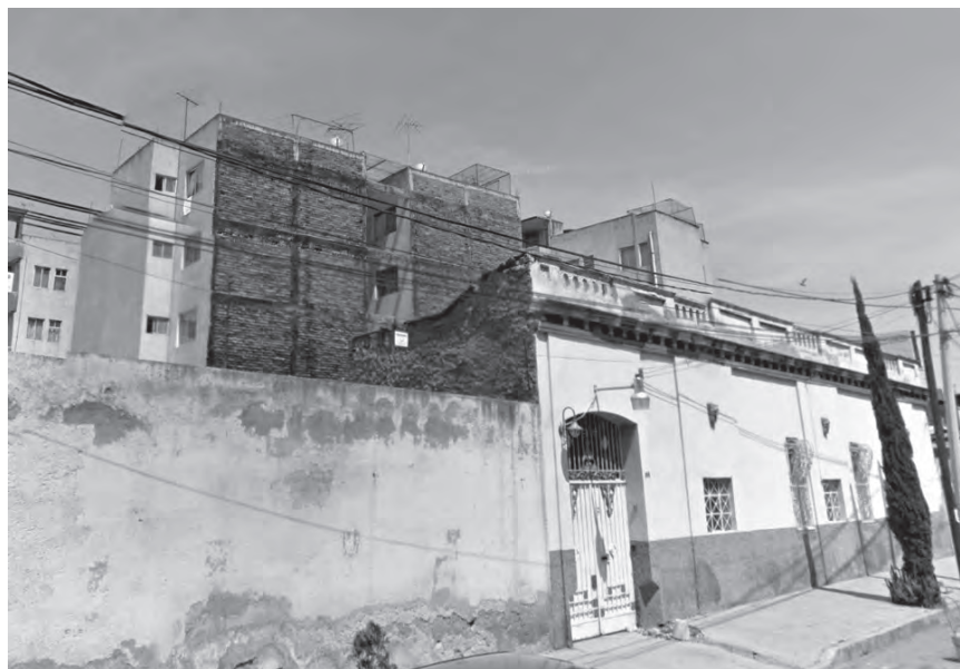
[4] Proliferación de edificios multifamiliares, sobre todo al norte de la colonia. Vista de la calle Cedro. Foto: google earth 2013.
