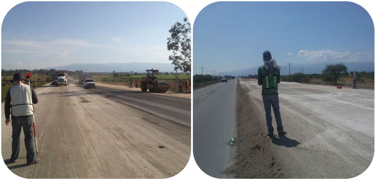
Imagen 4.24 .Levantamiento de secciones en capa subrasante
