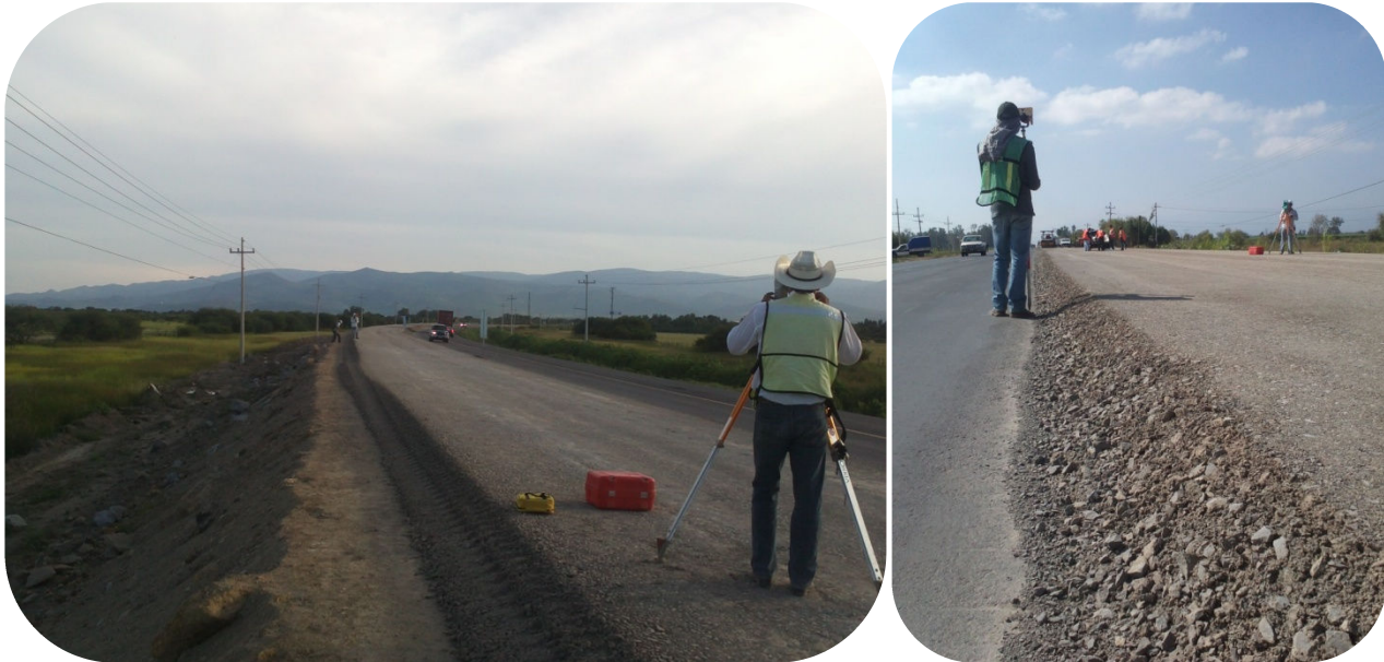
Imagen 4.26 Levantamiento de secciones en tramo de capa de base hidráulica.
