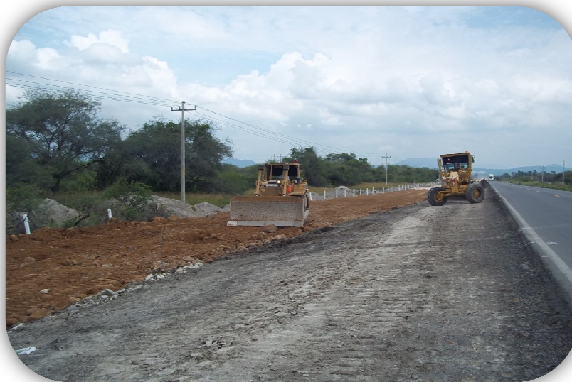
Imagen 3.1 Constructora llevando a cabo los procedimientos constructivos para el cuerpo de terraplén
