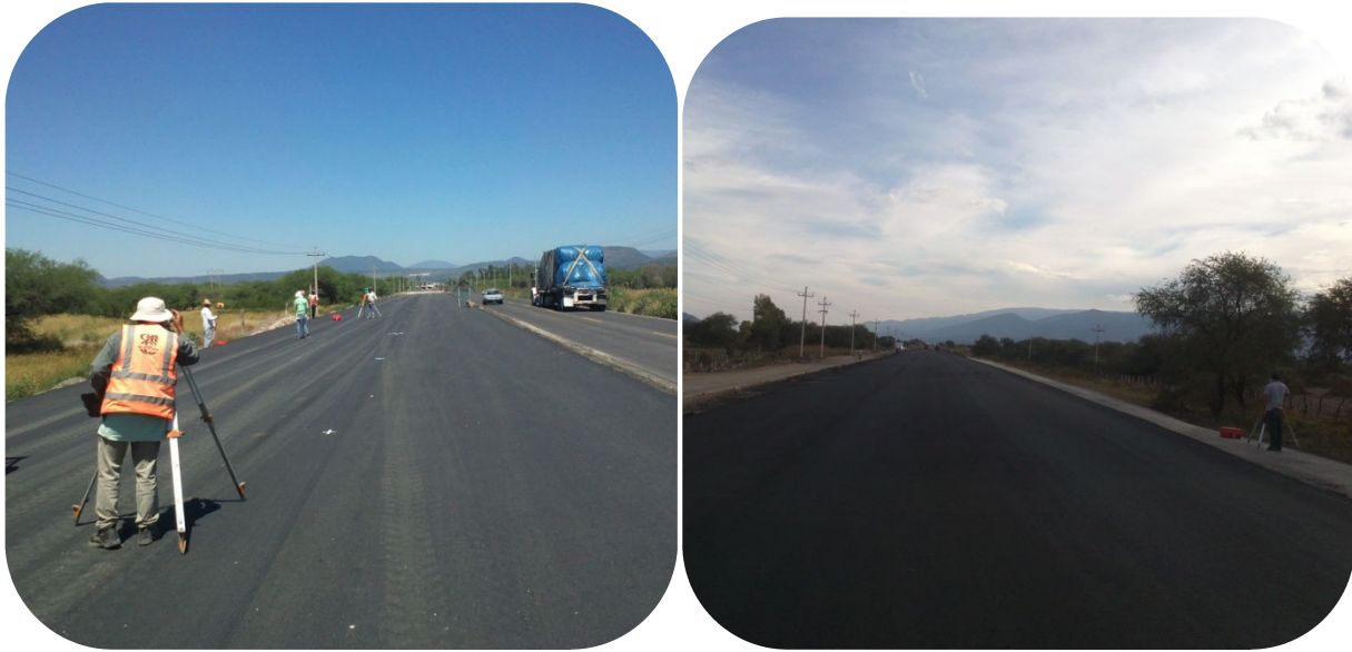
Imagen 4.30. Levantamiento niveles y secciones transversales en tramo terminado de carpeta asfáltica.
