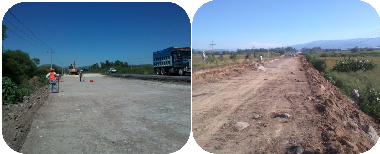
Imagen 4.22. Levantamiento de secciones en capa de cuerpo de terraplén
