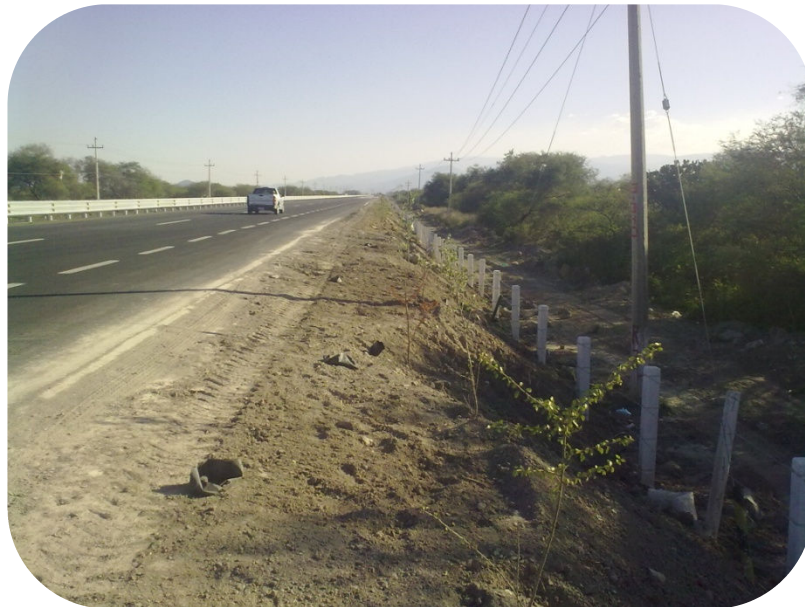
Imagen 3.3 Tramo de Carretera Terminado.
