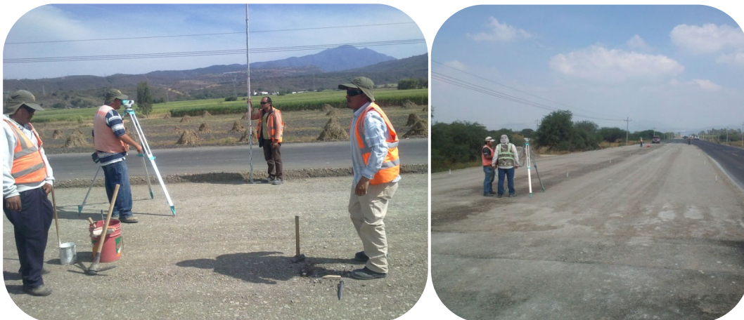
Imagen 4.27 Brigada de topografía de la supervisora verificando niveles en capa de base hidráulica.
