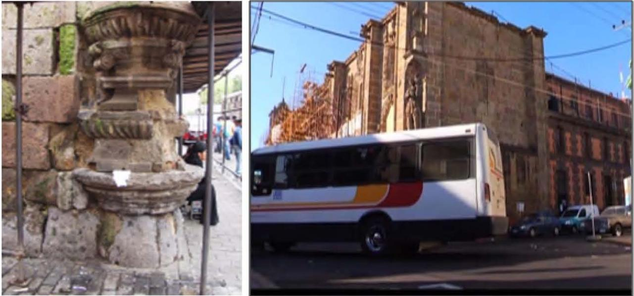
**Figura 1.5:** Detalles de alteraciones en la esquina norte del templo de Santa Mónica. Pérdida de material debido al tránsito vehicular [10].
