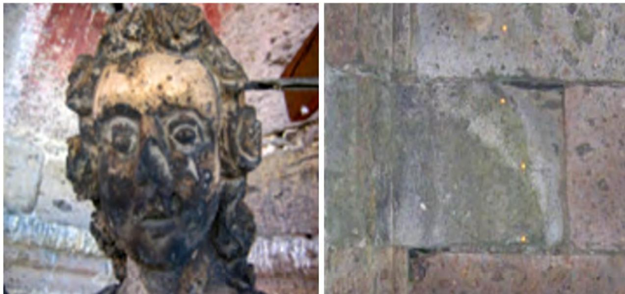
**Figura 1.4:** Detalles de alteraciones en la fachada del templo de Santa Mónica. Costra negra (izq) y Eflorescencia de sales (der.) [9].
