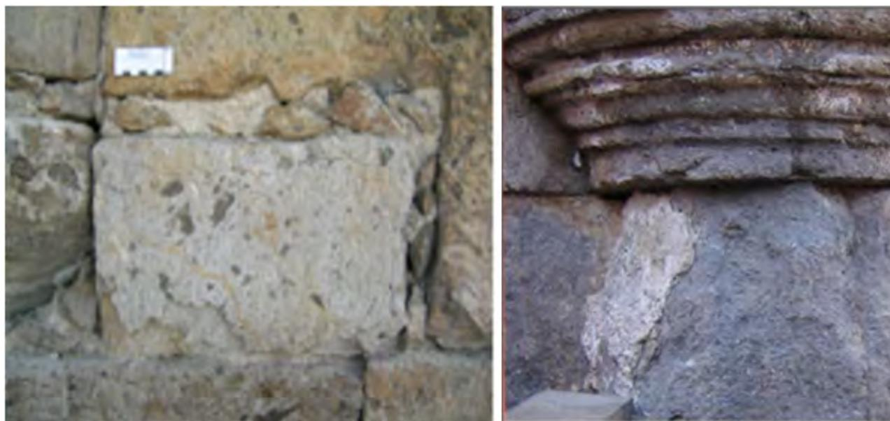
**Figura 1.3:** Detalles de alteraciones en la fachada del templo de Santa Mónica. Exfoliación (izq) y Erosión (der.) [8].
