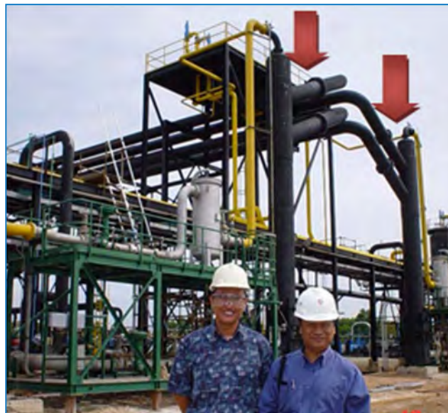
Figura 4.11 Separadores GLCC para manejo de baches en Duri, Indonesia (Kouba et al., 2006).
