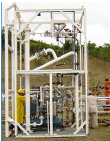
Figura 4.14 Separador GLCC para aforo en tierra de aplicación en México (IMP).
