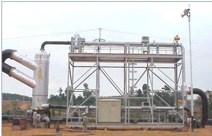
Figura 4.7 Medidor multifásico más grande del mundo ubicado en Minas, Indonesia (Kouba et al., 2006).
