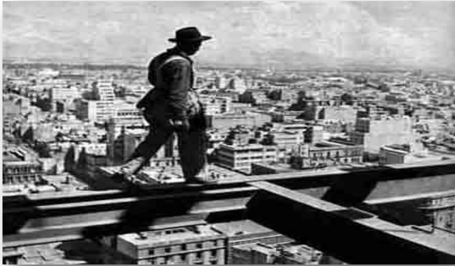
Figura 2.2 Construcción de Torre Latinoamericana.
