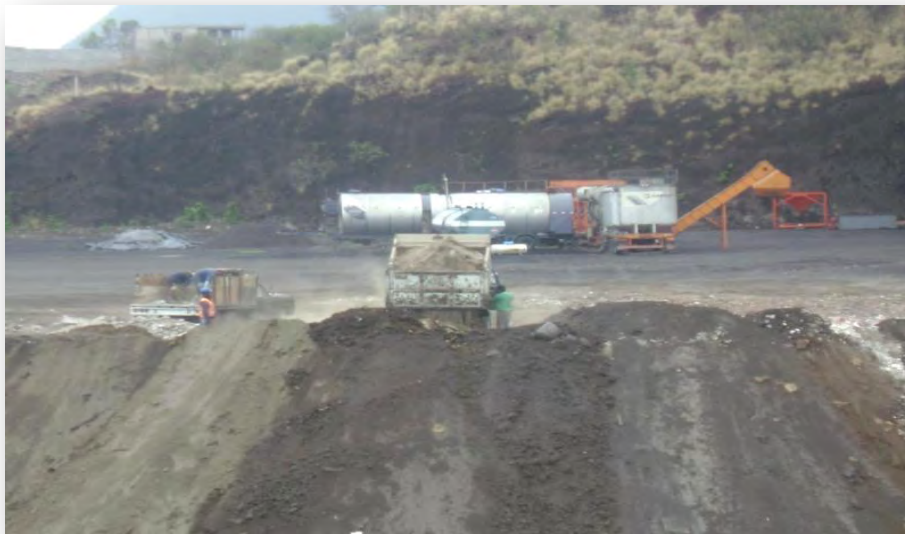
Fotografía 5.1 Recepción y depósito de escombro. Fotografía por el Autor.
