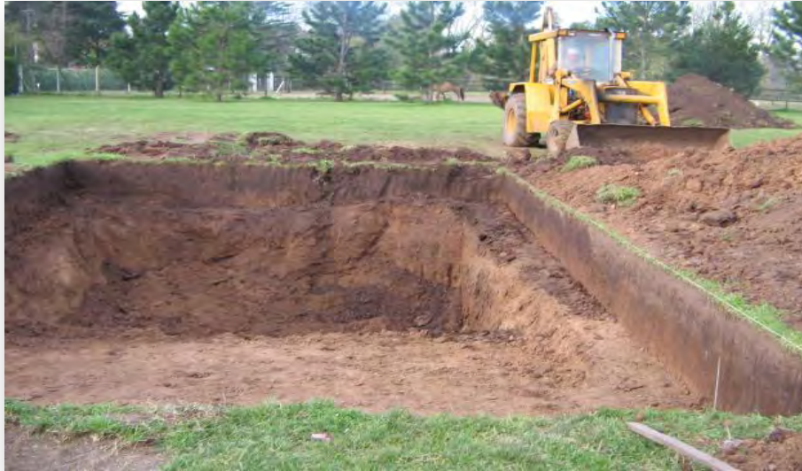
Figura 5.2 Residuos de excavación.
