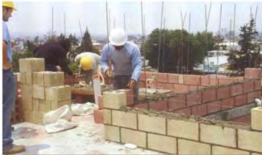
Figuras 5.29 Construcción con Block de concreto.
