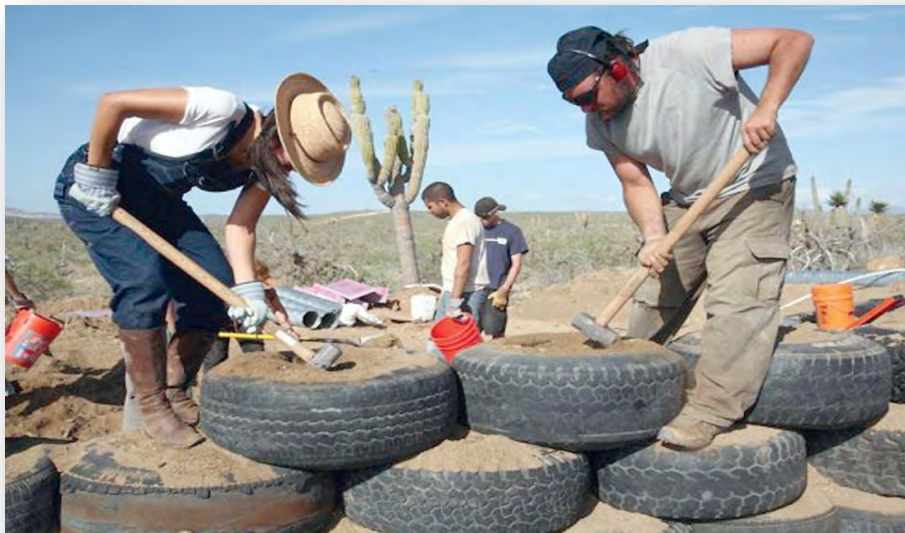
Figura 5.18 Construcción de casa Ecológica.
