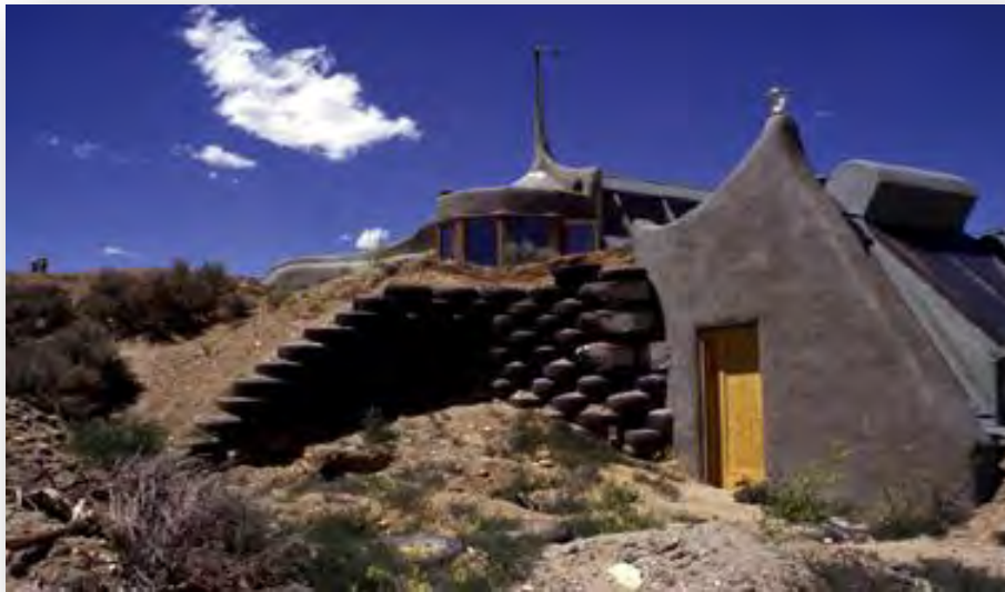
Figura 5.17 Casa ecológica con muros de llantas de autos.
