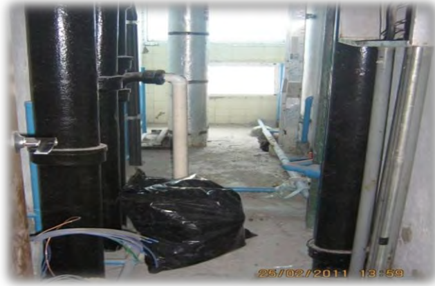
Figura 4. Almacenamiento por piso.
