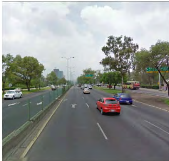
Periférico Sur a la altura de Boulevard de la luz
