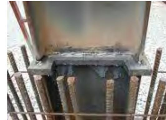
DETALLE CONSTRUCCIÓN DE COLUMNAS MIXTAS
