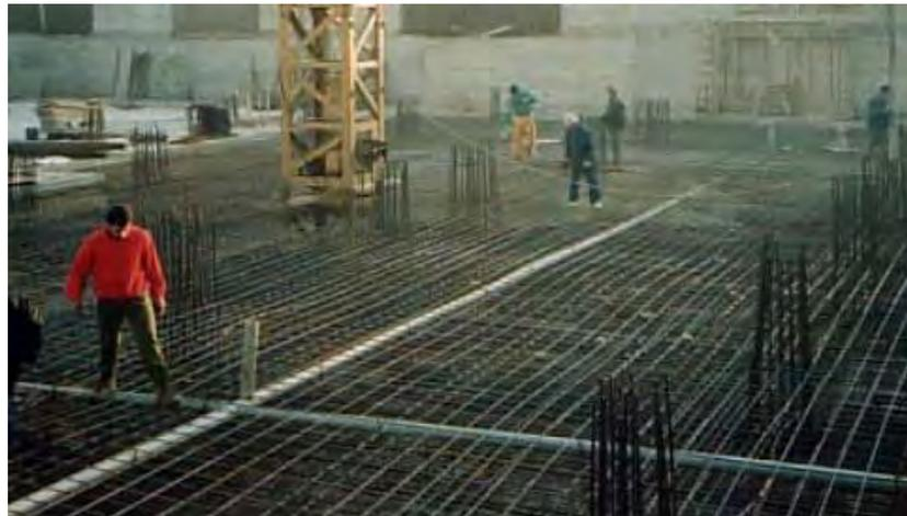
DETALLE LOSA DE CIMENTACIÓN
