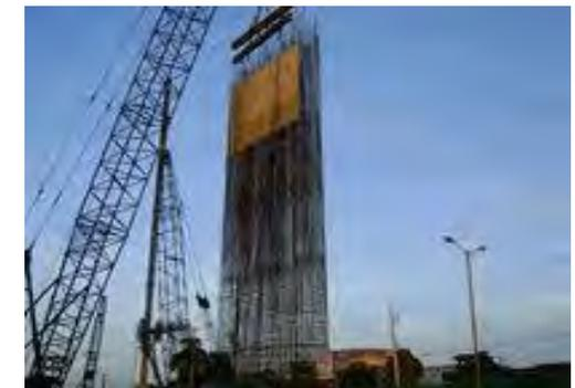
DETALLE CONSTRUCCIÓN DE MURO MILAN.5
