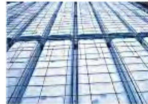
**FORJADO DE COMPRESIÓN DE LOSA ENCASETONADA**
