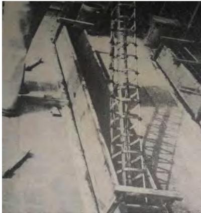
**Fotografía 28 Encofrado de la viga - Fuente: Nuevas técnicas de construcción con bambú, Universidad Nacional de Colombia, 1976**
