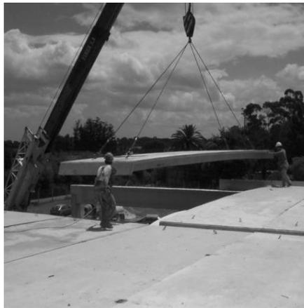
Fotografía 21 Transporte y montaje de elementos de prefabricación pesada - Fuente: Internet
