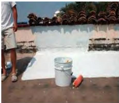
Fotografía 35 Impermeabilizante para cubierta proveniente de llantas - Fuente: WWW.IMPERLLANTAS.COM
