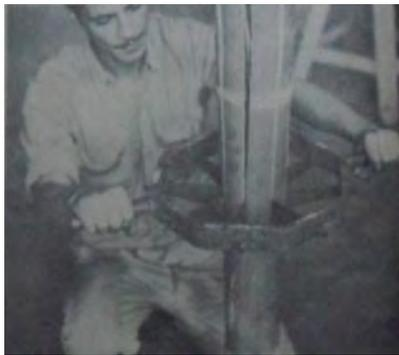
Fotografía 24 Cortadora radial - Fuente: Nuevas técnicas de construcción con bambú, Universidad Nacional de Colombia, 1976
