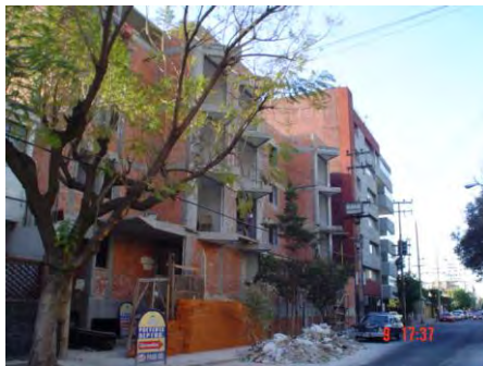
Fotografía 4: en este caso vemos que en fachada se maneja el tabique de barro rojo recocido
