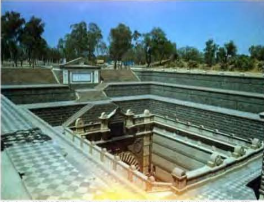
Caja colectora del Túnel de Tepic, se observa parte de la entrada a la boca del túnel. Tepic, Estado de México, 1973. Archivo Histórico del Agua, Colección Fotográfica, expediente 11811
