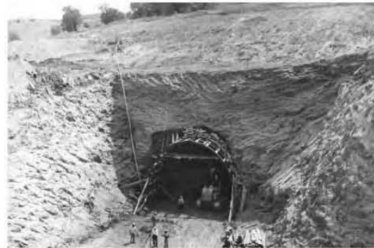
Portal de entrada de uno de los túneles que componen el Interceptor del Panero, aún en construcción. Tepic, Estado de México, E. Archivo Histórico del Agua, Colección Fotográfica, expediente 8101
