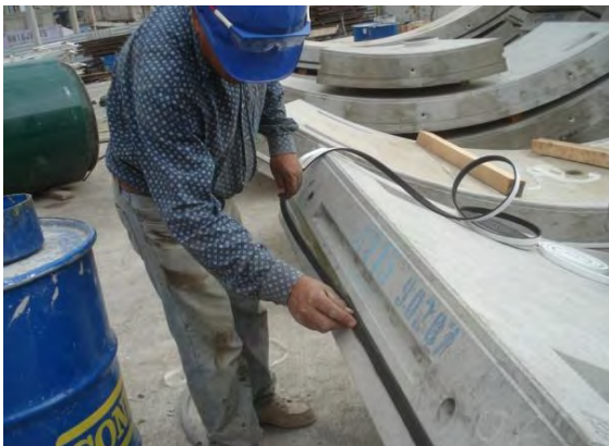
Fig. 6 Colocación de sellos en las dovela
