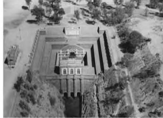
Vista general de la caja colectora del Túnel de Tepic, se observa el muro de mamparas, las compuertas y parte del Gran Canal. A la izquierda se encuentra la antigua estación del tren. Tepic, Estado de México, 1973. Archivo Histórico del Agua, Colección Fotográfica, expediente 44642
