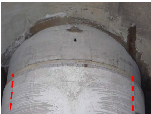
Vista de líneas de Inyección y cepillos de acero.
