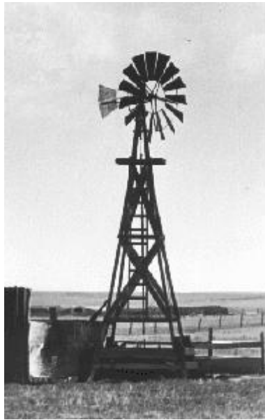
Figura 2. 1 Molino de viento de hojas de acero bombeando de agua en el medio oeste norteamericano (finales de 1800) [7]
